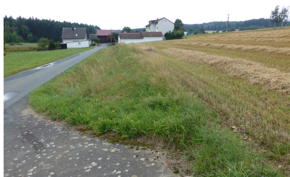
Hot-Spot 45 Blick nach Südwest
