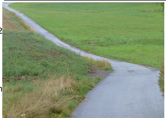
Hot-Spot 2 Straße quert Ablaufsenke
