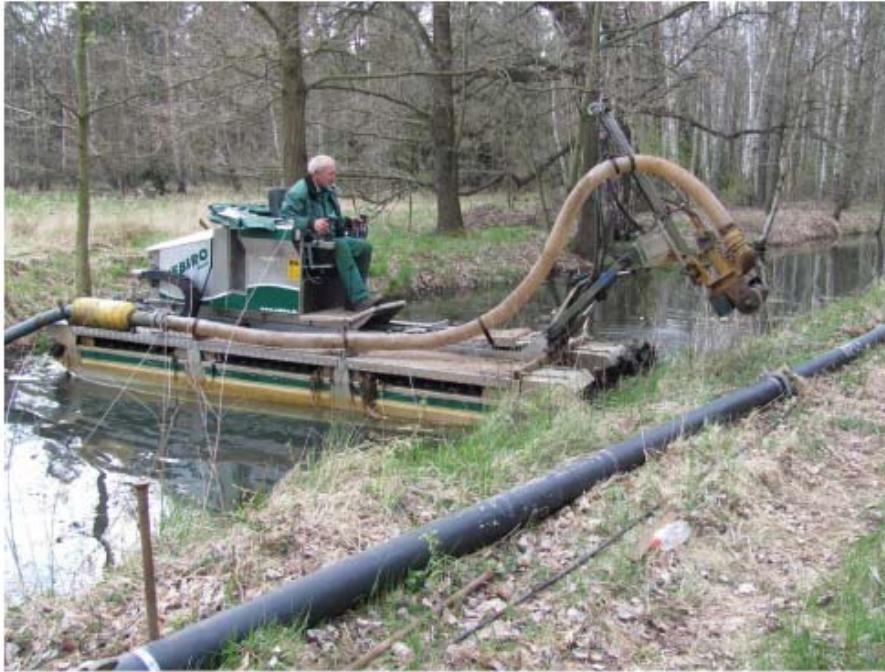
Abb. 6,5: Beräumung der Struga mit Amphibienfahrzeug
