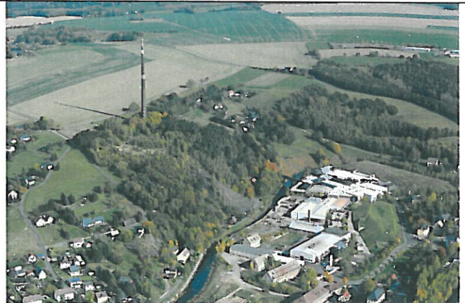
Abb. 3: eh. Hütte Halsbrücke, 2012
