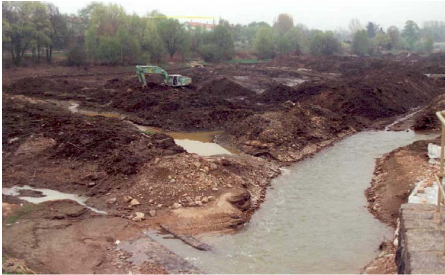
Abb. 10.3: Entlandung der Vorsperre Malter, Dippoldiswalde
