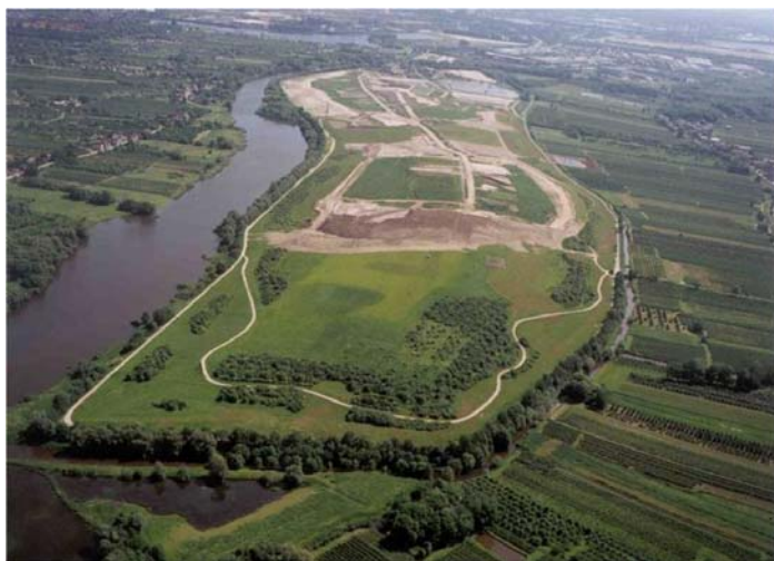
Abb. 8.2: Schematischer Aufbau (oben) und Luftbild der Deponie Francop aus dem Jahr 2007 mit bereits fertig gestellten Bereichen (unten)
