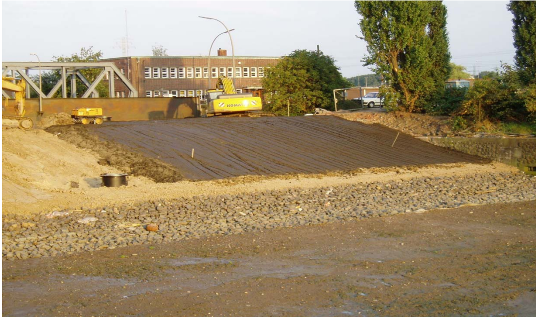
Abb. 7.1: Einbau eines Testfeldes im Böschungsbereich bei Tideniedrigwasser in Hamburg
