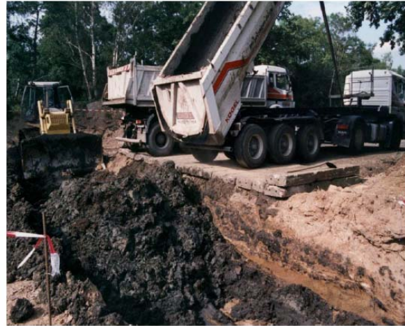
Abb. 10.2: Entlandung der Vorsperre Oehna und Einlagerung des entnommenen Sediments in den Steinbruch (Landestalsperrenverwaltung Sachsen)
