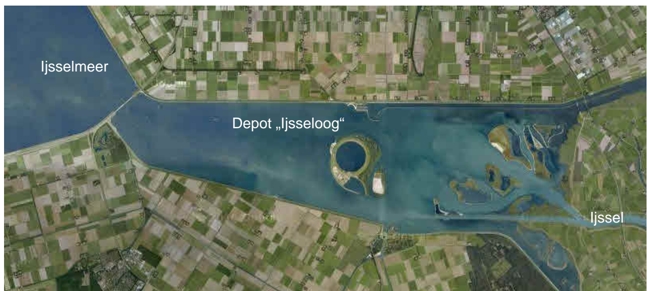
Abb. 5.9: Lage des Baggergutdepot Ijsseloog im Ketelmeer (Google)
