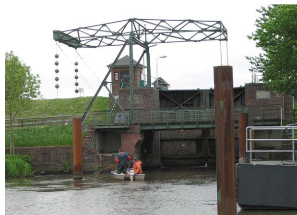
Stemmtore an der Wilster Au/Stör, automatisch schließend bei Flut
