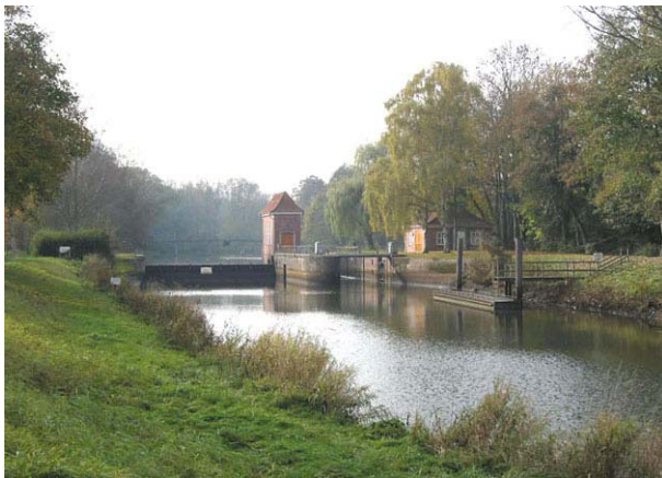
Wehr- und Schleusenanlage Bremervörde an der Oste
