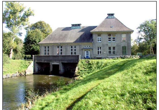
Hechtfortschleuse mit Wasserkraftwerk an der Elde-Müritz-Wasserstraße
