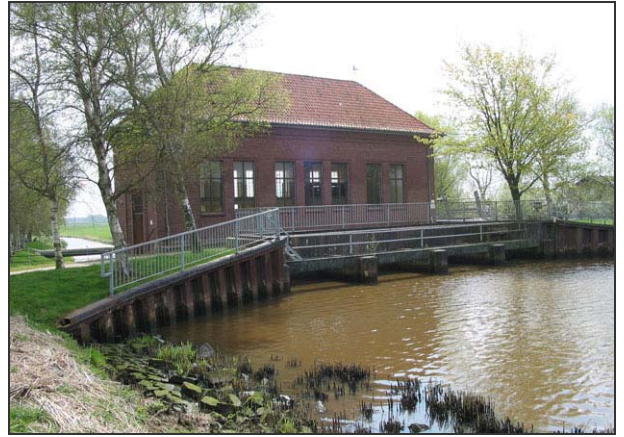
Vaalermoor Schöpfwerk, Wilster Au/Nord-Ostsee-Kanal
