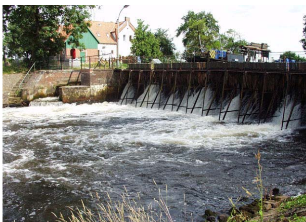
Nadelwehr bei Schleuse Wittdorf an der Ilmenau
