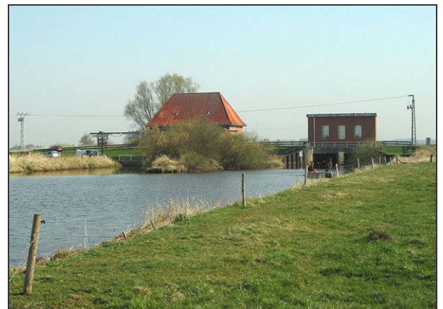
Abschlussbauwerk der Mehe - links Schöpfwerk, rechts Einrichtung mit Stemmtoren
