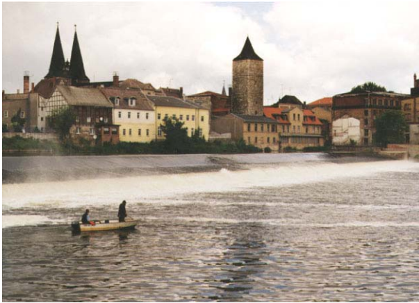
Stadtwehr in Calbe an der Saale
