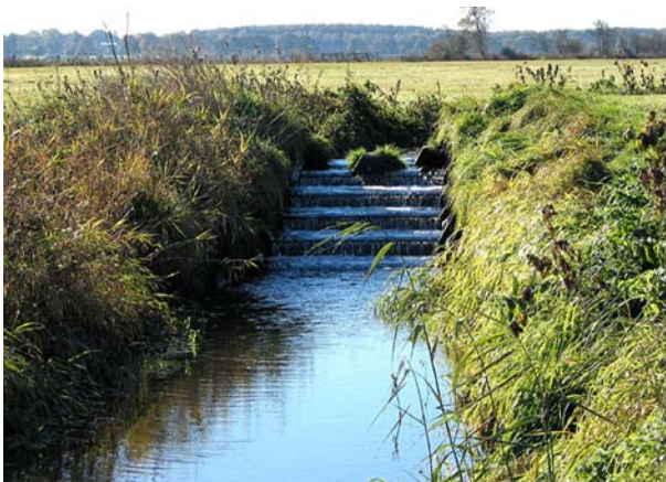
Kaskadenabsturz im Grenzgraben
