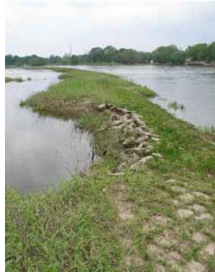
Zustand vor Baubeginn; Quelle: WSA Dresden
