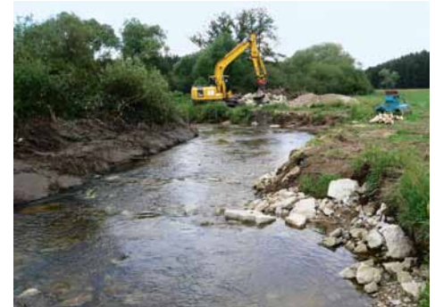
Während der Baumaßnahmen
