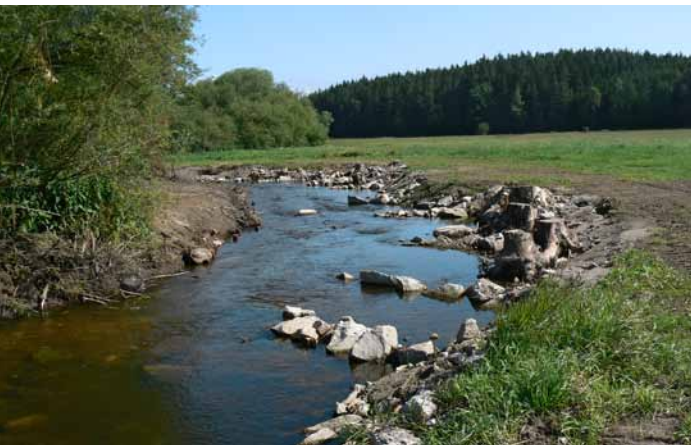
Mit Abschluss der Arbeiten war die ursprüngliche Beschaffenheit dieses Abschnittes wiederhergestellt.
