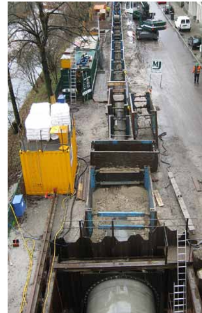
Blick auf Baugrube, Straße und Gewässer; Quelle: Fachvereinigung Betonrohre und Stahlbetonrohre e.V
