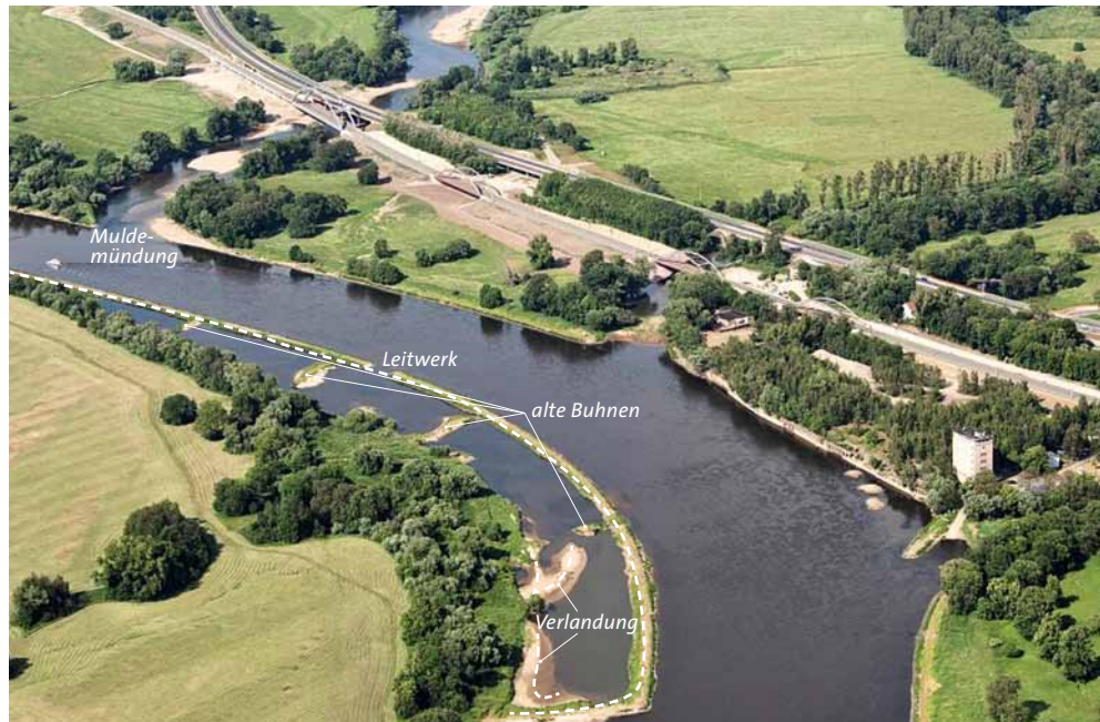
Leitwerk Dessau-Wallwitzhafen vor Beginn der Bauarbeiten; Quelle: Andreas Hilger
