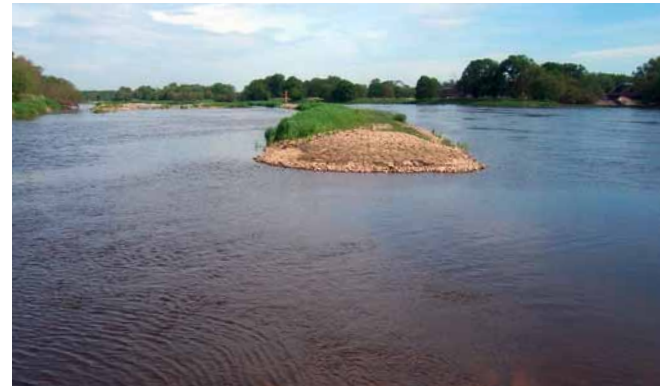
Leitwerksöffnung hergestellt; Quelle: WSA Dresden
