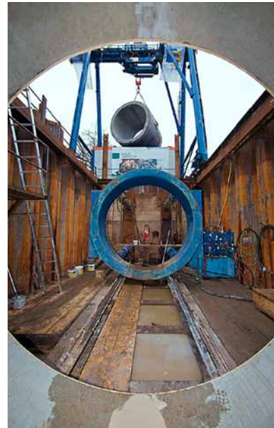
Stauraumkanal Weigandufer, in der Startbaugrube; Quelle: Berliner Wasserbetriebe
