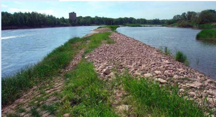
Leitwerk unmittelbar nach der Instandsetzung, 2012; Quelle: WSA Dresden
