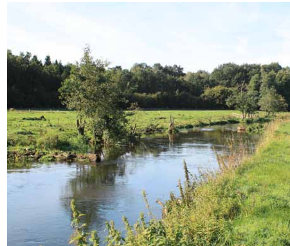
Totholzelemente als Strömungslenker für eine planmäßige Erosion der Störufer; Quelle: Hans-Joachim Paulsen
