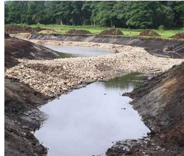
Eine Sandfangtasche im Bau. Sie wird die mit der Strömung ankommenden Sandfrachten abfangen. Quelle: Hans-Joachim Paulsen
