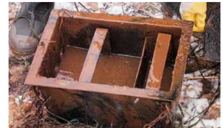
Geöffneter Sedimentationskasten; Quelle: LAF
