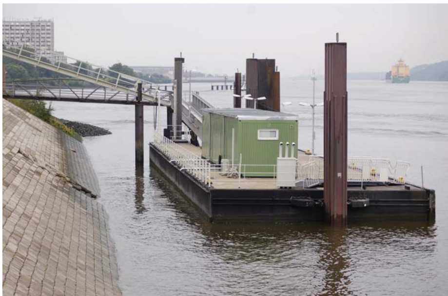
Abb. 4-1: Gewässergütemessstation bei Seemannshöft (Quelle: WGE)
