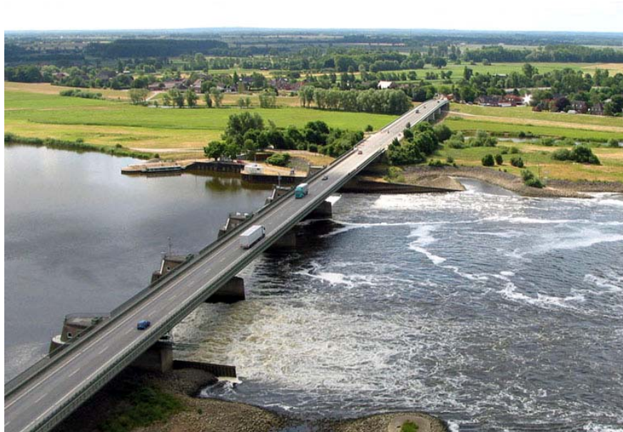
Abb. 2-6: Wehr Geesthacht, Strom-km 586, Blick auf die Fischwechseinrichtung am Südufer (Quelle: WGE)
