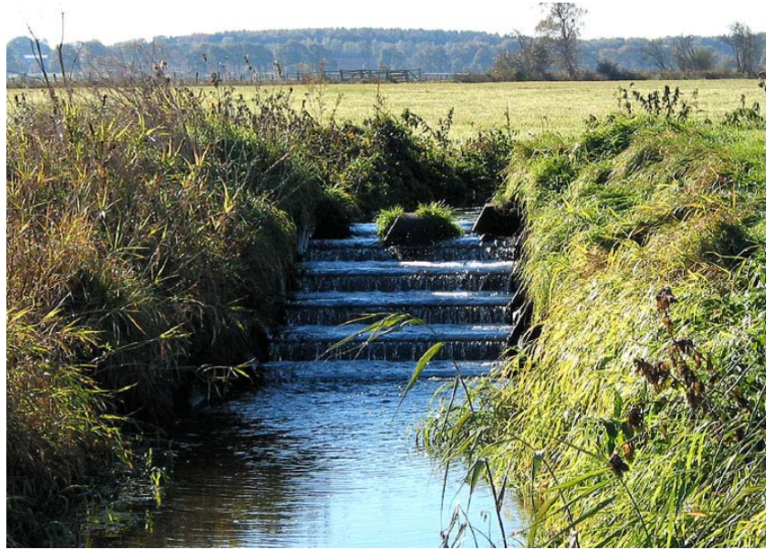
Abb. 5-3: Kaskadenabsturz im Grenzgraben (Quelle: WGE)
