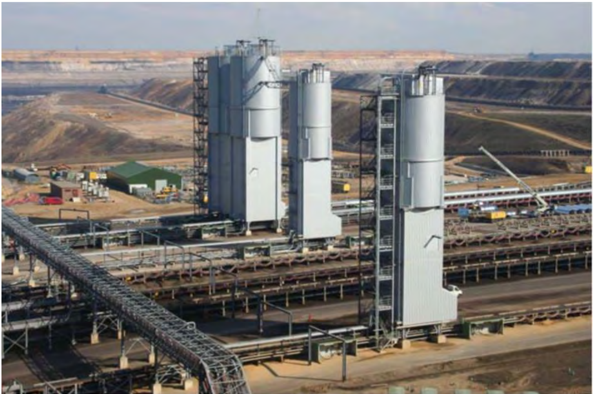
Abbildung 27: Kalksilos auf der Bandanlage im Tagebau Garzweiler II zur Kippenkalkung, Foto: Forkel, RWE 2009.
