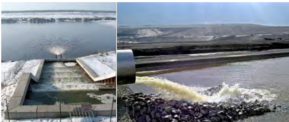
Abbildung 38: Einlaufkaskade der Zulaufanlage vom Oberen Landgraben zum Sabrodter See (links, Foto: IWB, 2006). Flutung des Großbräschener Sees (rechts, Foto: LMBV, 2007).
