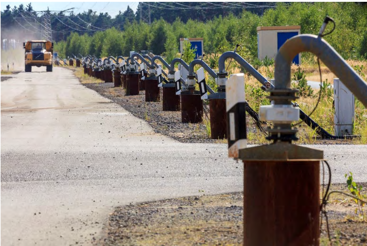
Abbildung 16: Randriegel mit Vertikalfilterbrunnen, © LE-B, Foto: Rainer Weisflog.
