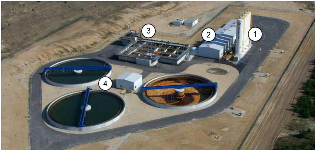
Abbildung 31: Grubenwasserbehandlungsanlage Tzschelln im Tagebau Nochten (LE-B) aus der Vogelperspektive mit (1) Kalksilos, (2) Betriebsgebäude, (3) Misch- und Dosierstrecken sowie (4) Rundbecken (Foto: Hartmut Rauhut).
