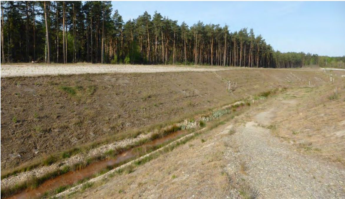
Abbildung 21: Dauerhafte nachbergbauliche Grundwasserregulierung durch den Südgraben Altdöbern, Foto: Uhlmann, IWB, 2020.
