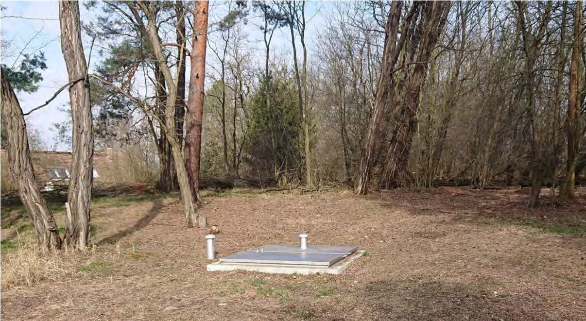
Abbildung 30: Brunnen eines Brunnenriegels an der Kleinen Spree zum Abfangen eisenbelasteten Grundwassers vor dem Eintritt in den Fluss (Foto: LMBV).
