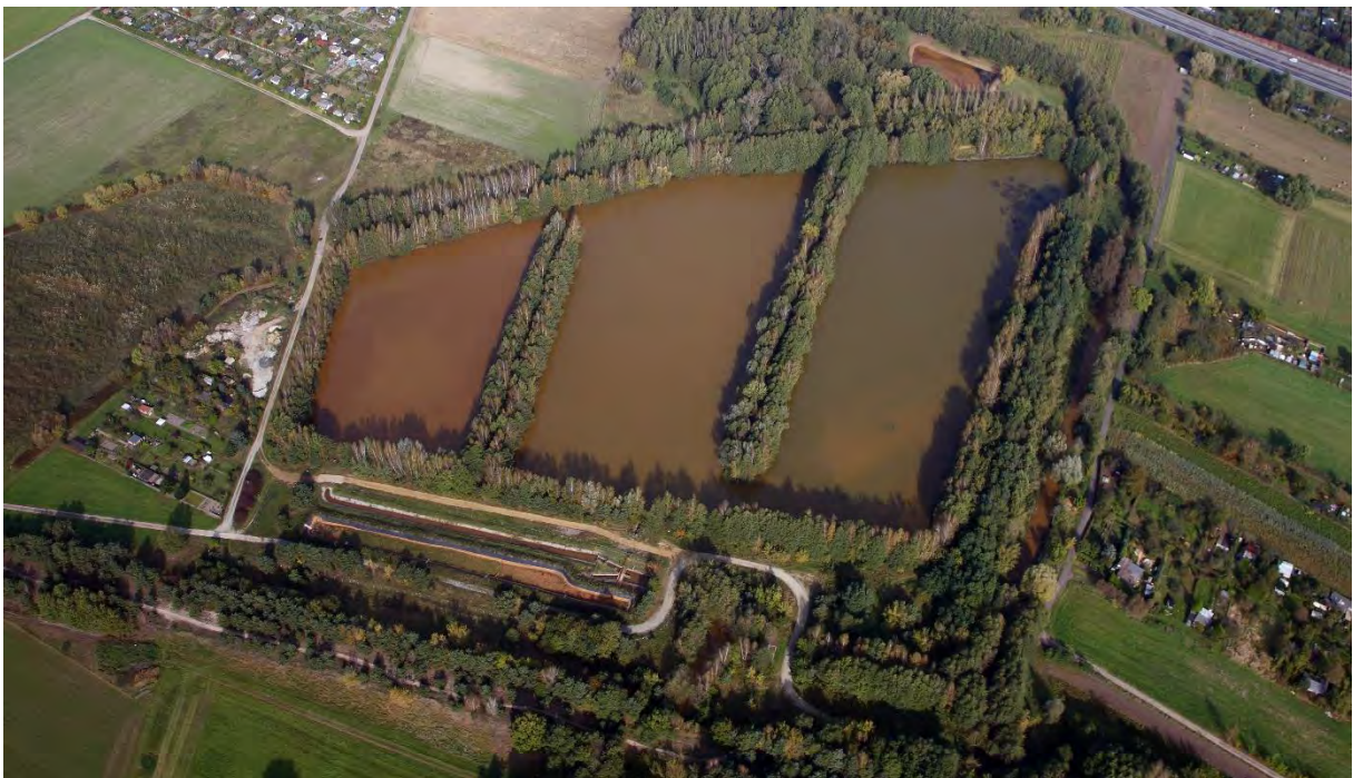
Abbildung 36: Hybride naturräumliche Wasserbehandlung eines eisenreichen, nicht säuregenerierenden Wassers in einer oberirdischen hybriden Anlage (GWRA Vetschau, Foto: Hartmut Rauhut, 2014).
