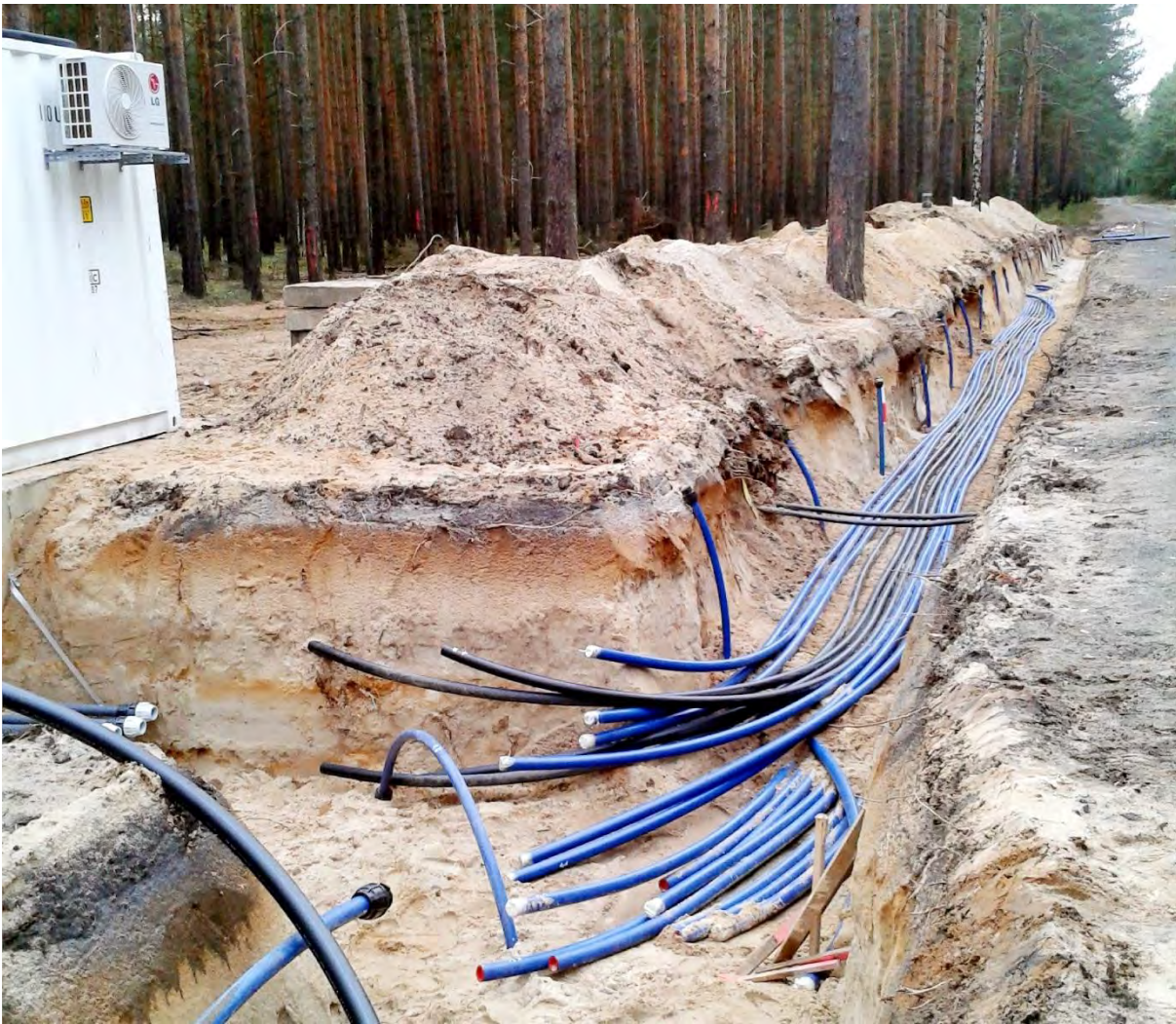
Abbildung 34: Versuchsanlage zur heterotrophen Sulfatreduktion im Grundwasser am Altarm der Spree (Foto: FIB, 2014).
