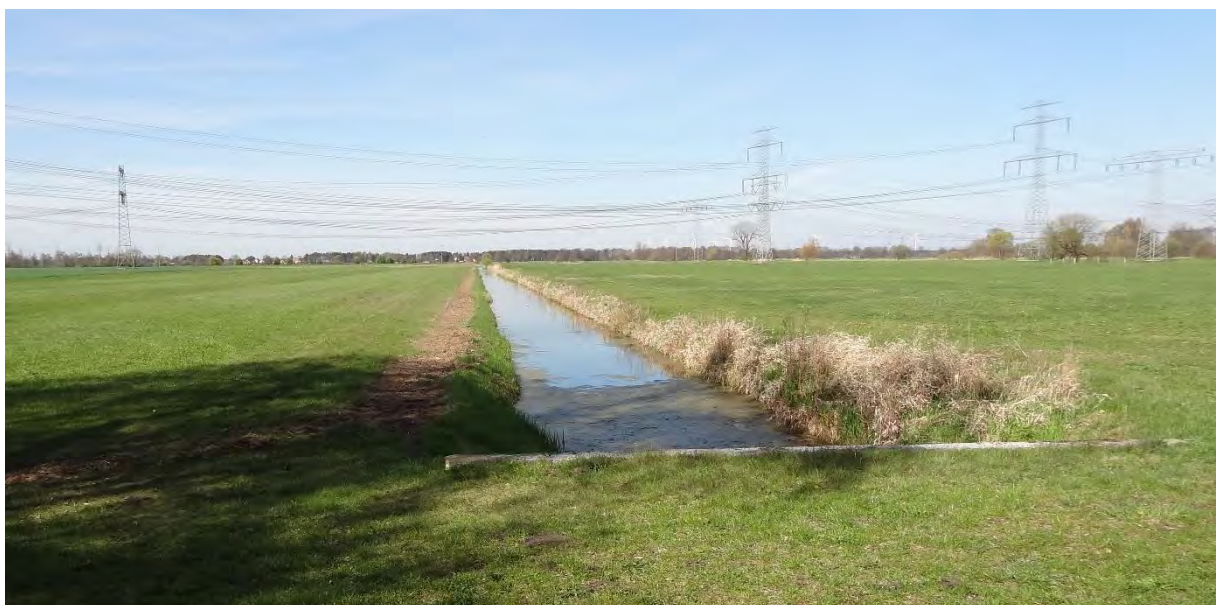
Abbildung 18: Infiltration von behandeltem Sumpfungswasser aus der GWRA Jänschwalde in den Laßzinswiesen, Tagebau Jänschwalde, Quelle: LE-B.
