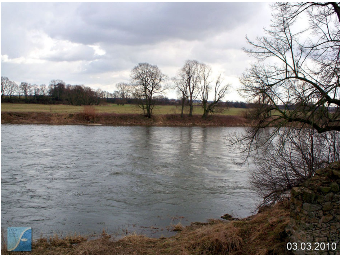
Abb. 10: Mulde Wehr Walzig – Seitenansicht nach Rückbau 2010
