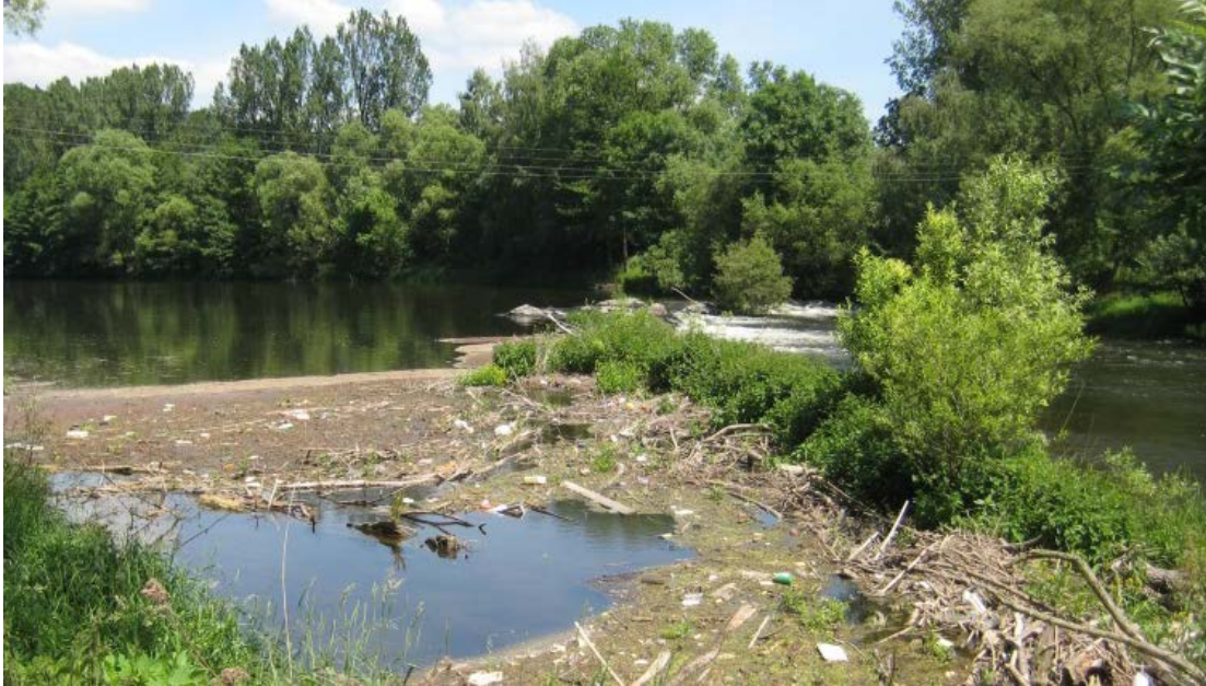
Abb. 14: Wehranlage Fischersdorf in der Saale vor Umgestaltung
