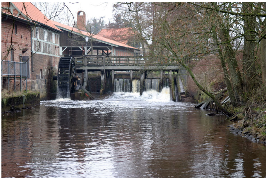
Abb. 5: Wehr Standort Sittensen an der Oste – vor Umbaumaßnahme
