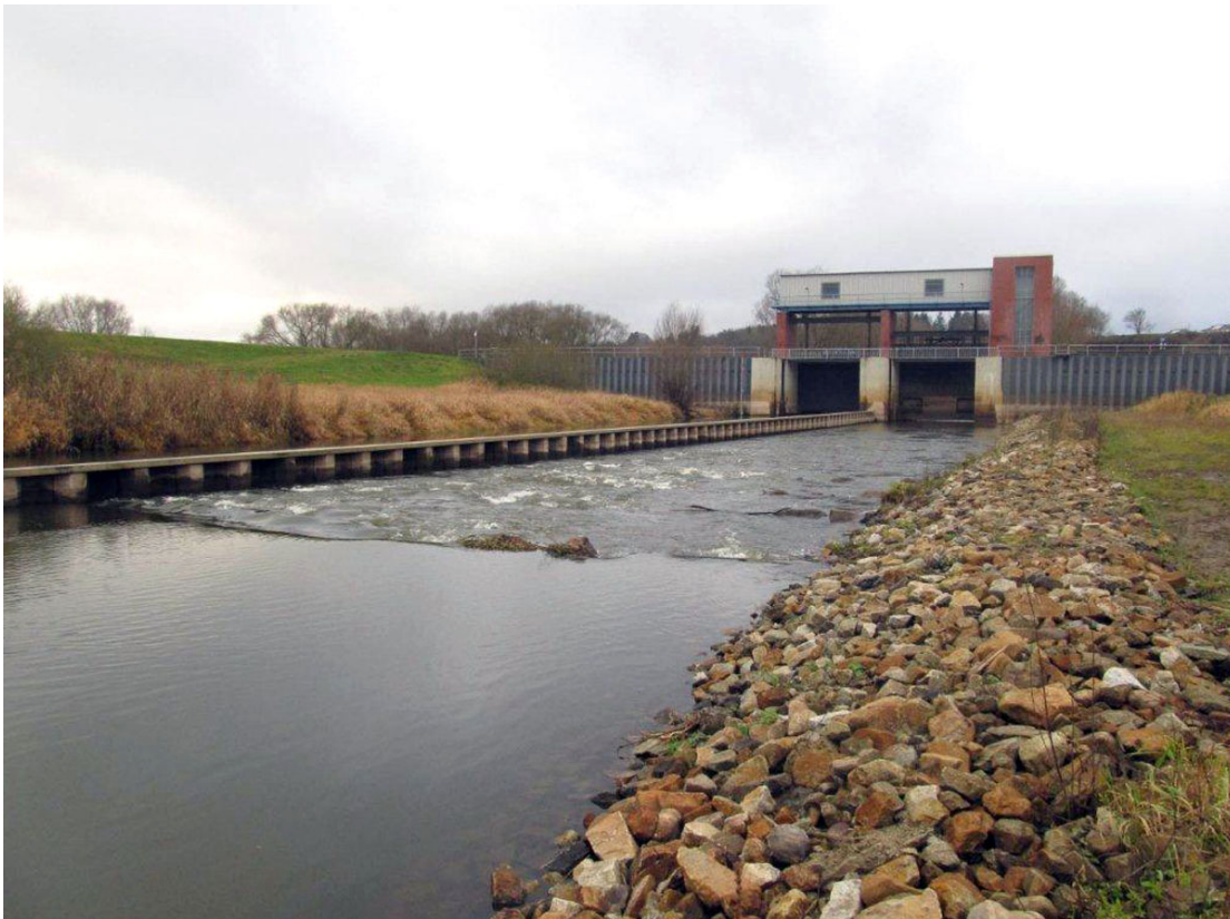
Abb. 4: Fischaufstiegsanlage Sudeabschlusswehr in Boizenburg (Foto: LUNG M-V Jan. 2014)
