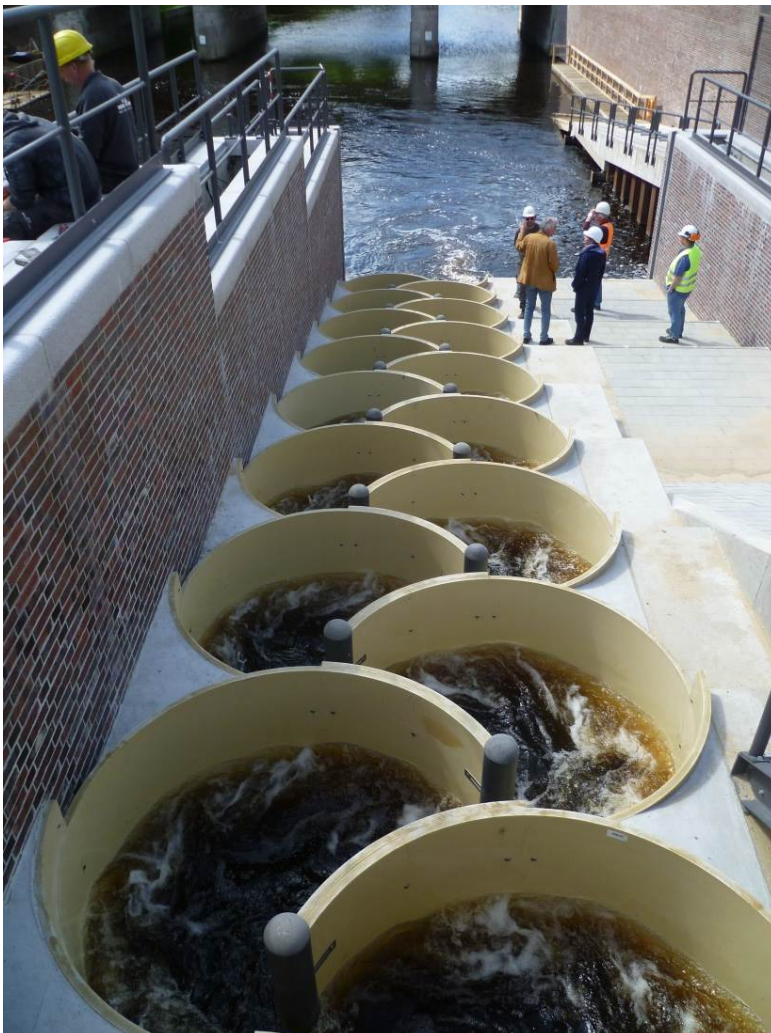
Abb. 3: Mäanderfischpass an der Fuhlsbüttler Schleuse
