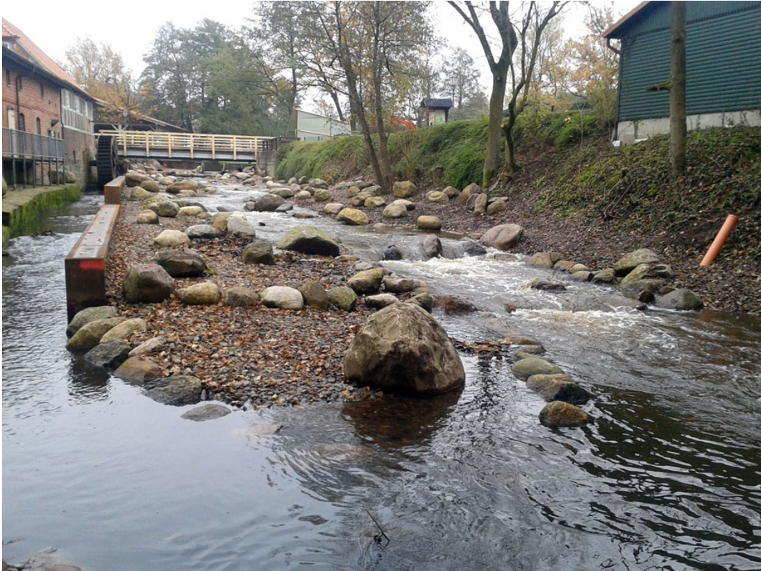
Abb. 6: Wehr Standort Sittensen an der Oste – Sohlgleite nach Umbaumaßnahme
