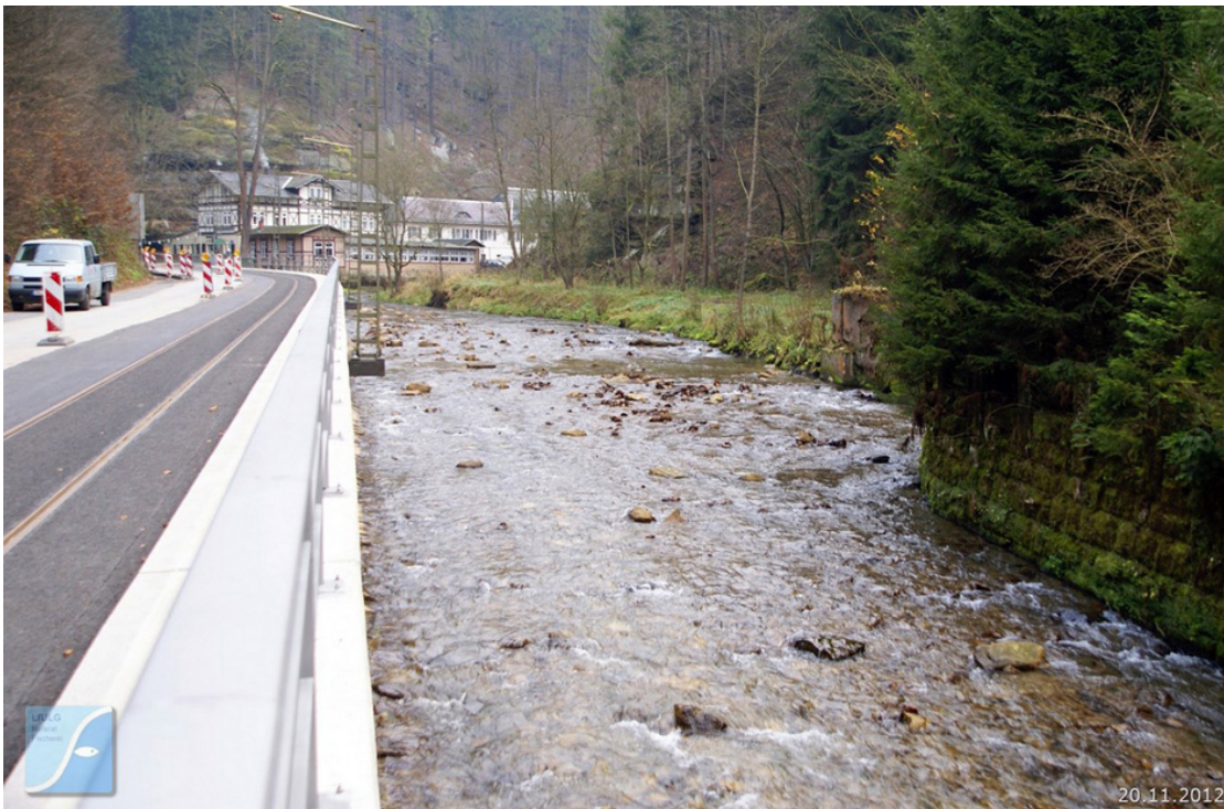
Abb. 8: Kirnitzsch Wehr Haidemühle – Ansicht nach Rückbau 2012
