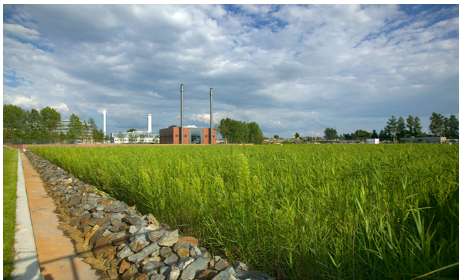
Abbildung B-3: Retentionsbodenfilter Adlershof (Quelle: Institut für Stadtforschung und Strukturpolitik 2009)
