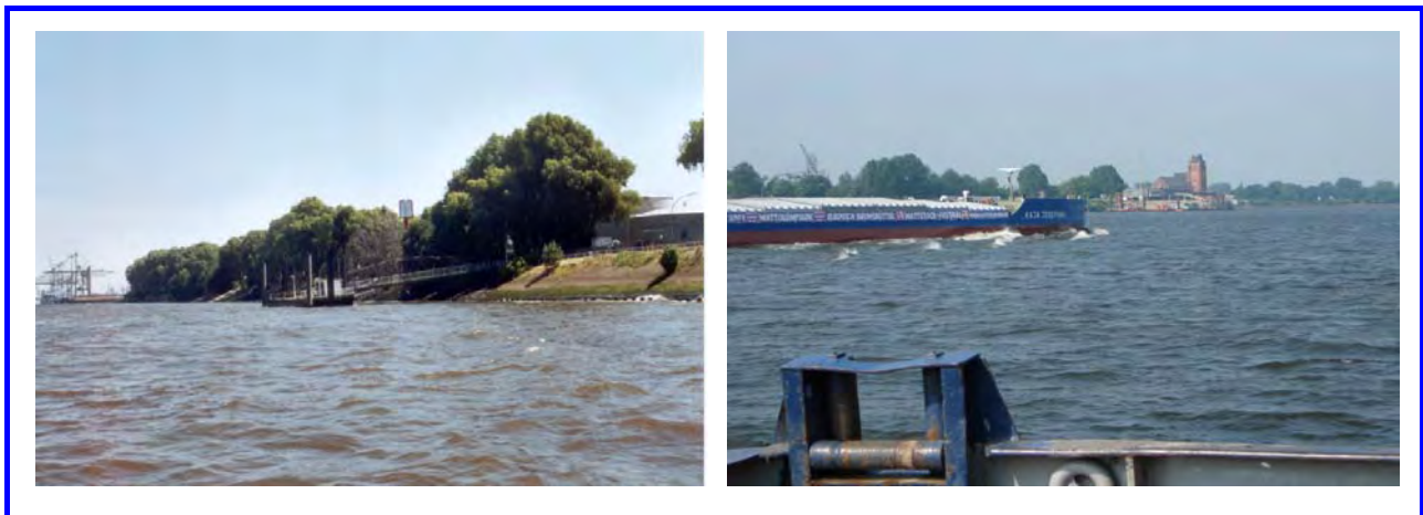
Abb. 6: Bubendey-Ufer/Seemannshöft; OWK Hafen – Querschnitt 5 Links: Bubendey-Ufer, Fähranleger (Südufer; Blick stromauf) und Rechts: Bubendey-Ufer bis Seemannshöft, Lotsenstation (Blick stromabwärts Richtung Südufer)
