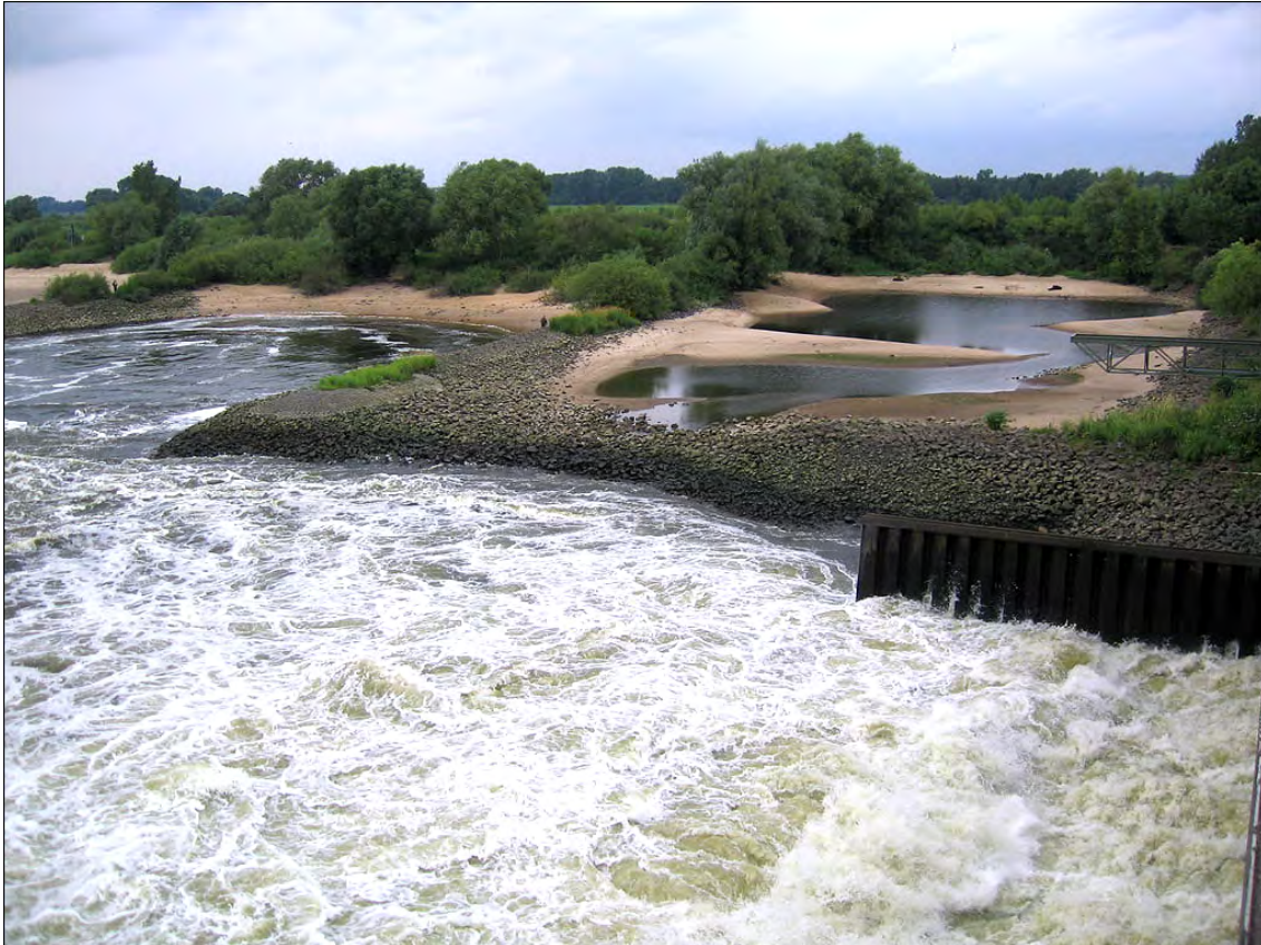
Abb. 3 Tosraum unterhalb des Elbewehres Geesthacht
