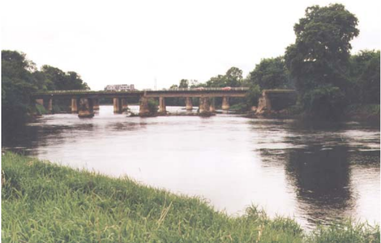
Abb. 7 Mulde, Fangort oberhalb der Straßenbrücke nach Roßlau
