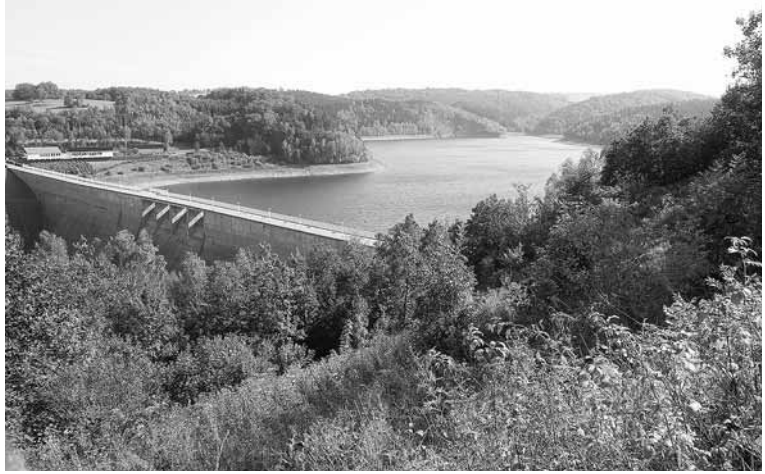
Die Talsperre Gottleuba im Osterzgebirge dient mit ihrem Stauraum von 13 Mio. m 3 der Trinkwasserversorgung und dem Hochwasserschutz und wird außerdem zur Energiegewinnung genutzt. Foto: Jörg Dehnert
