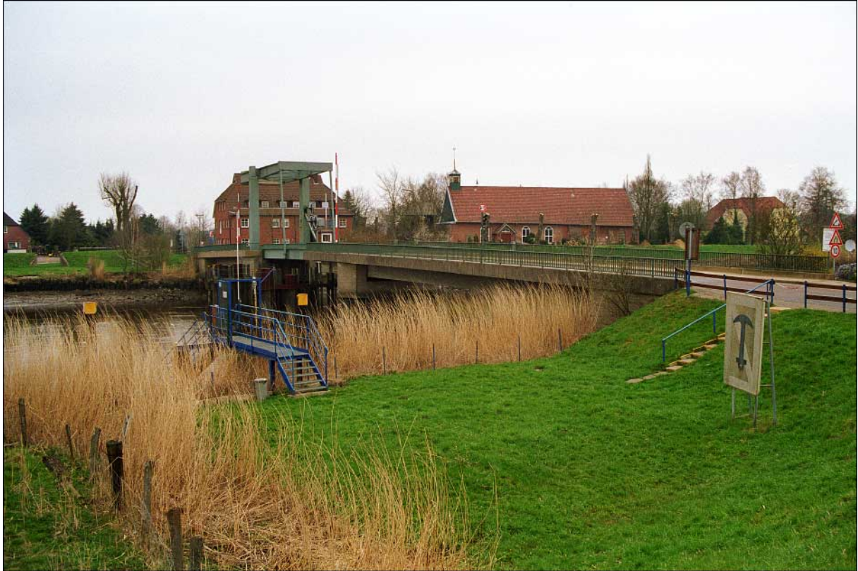
Abb. 4 Klappbrücke über die Stör bei Heiligenstedten
