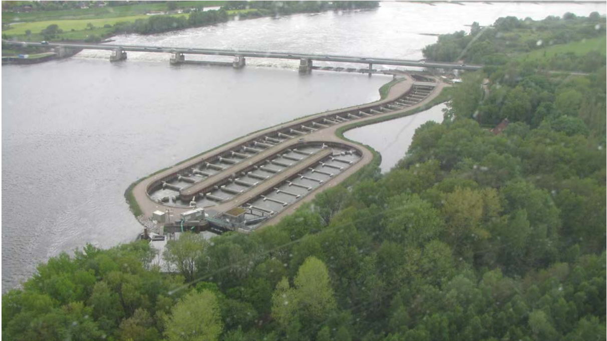
Abbildung 4-13: Bild des 2010 errichteten Doppelschlitzpasses und Wehr Geesthacht (Foto: FGG Elbe)
