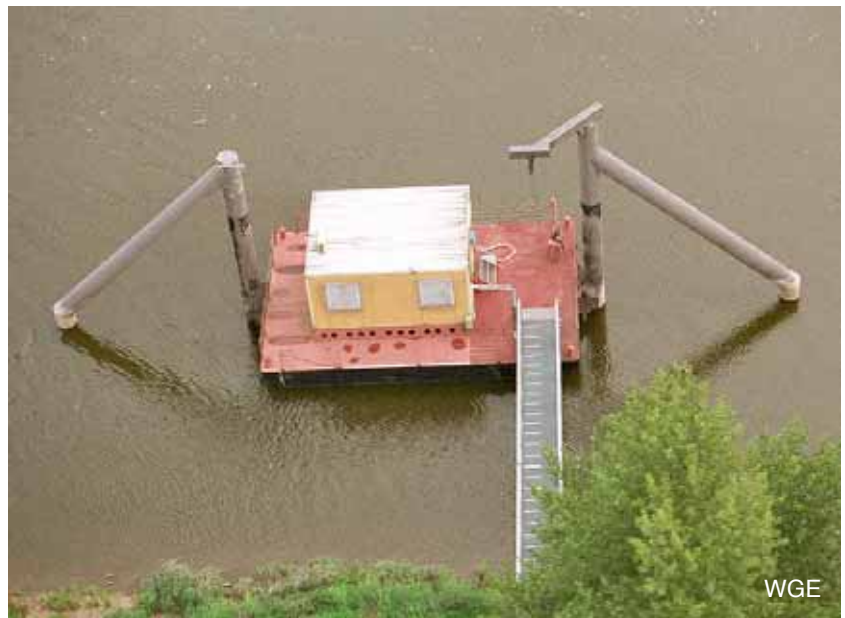
Abb. 8 automatische Messstation Magdeburg (linkes Ufer)
