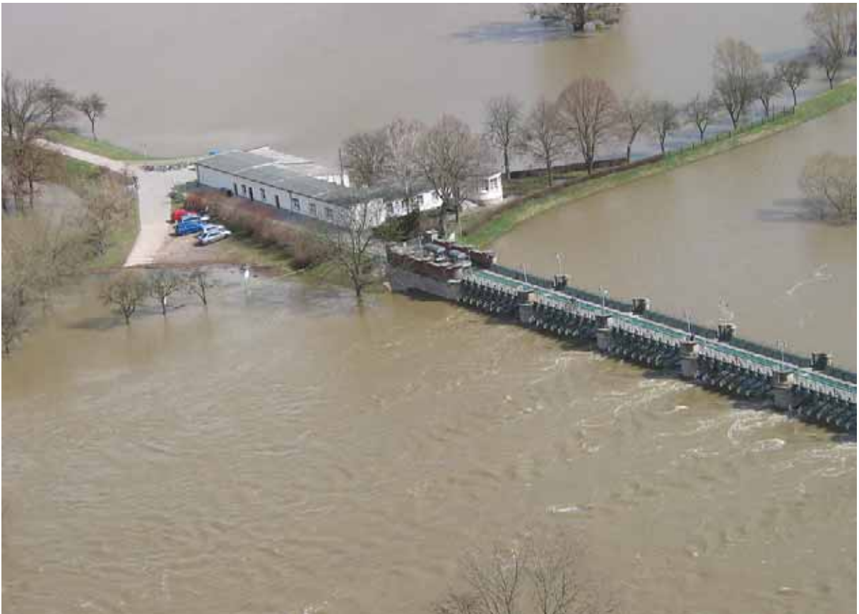
Abb. 65 Das Pretziener Wehr am Elbeumflutkanal bei Magdeburg am 5. April 2006
