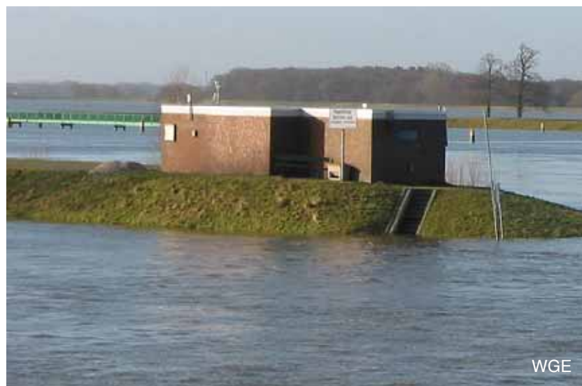
Abb. 9 automatische Messstation Schnackenburg (linkes Ufer)
