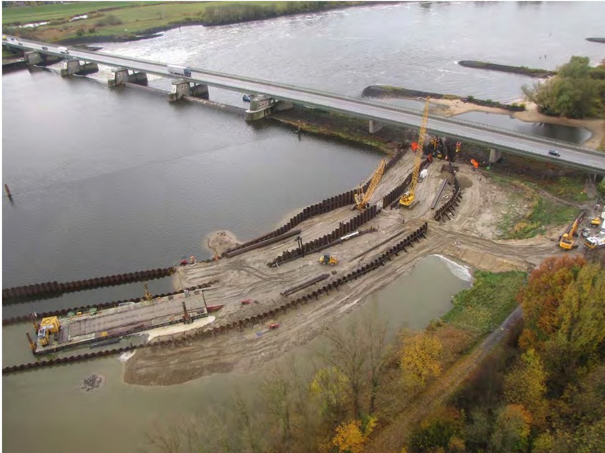
Abb. 9 Baustelle der Fischwechsellanlage am Nordufer des Wehres Geesthacht Foto vom 5. November 2009
