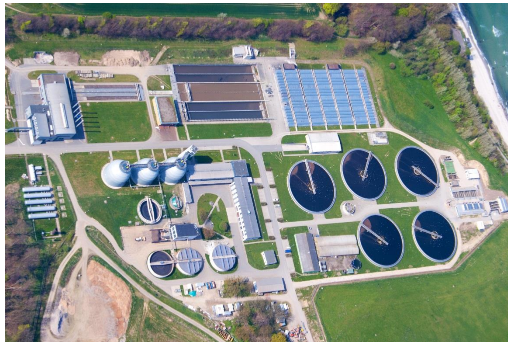
Klärwerk Kiel Bülk, https://de.wikipedia.org/wiki/Kl%C3%A4ranlage
