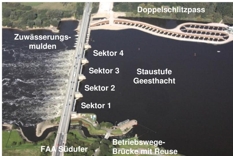
**Abb. 1: Anlagen an der Staustufe Geesthacht**
