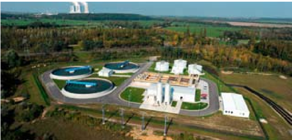
Grubenwasserreinigungsanlage Tagebau Vereinigtes Schleenhain
