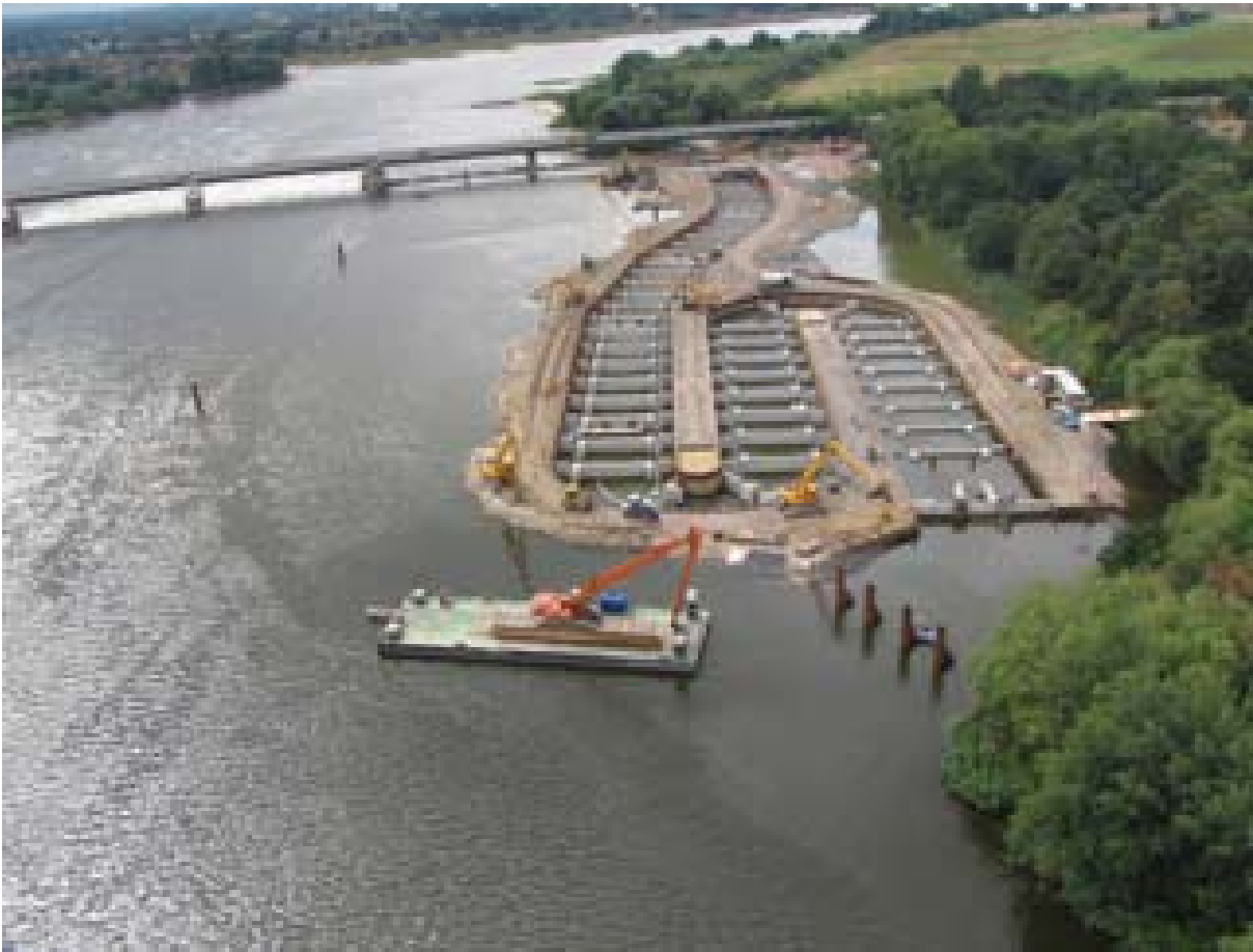
Fischaufstiegsanlage Geesthacht (Stand August 2010)
