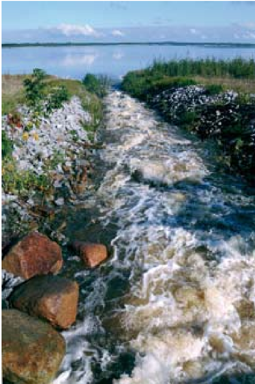
Wasserentnahme aus der Schwarzen Elster zur Flutung eines Bergbaufolgesees im sächsischen Teil des Lausitzer Braunkohlenreviers
