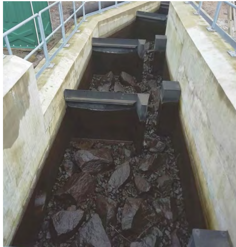
Schlitzpass der Fischaufstiegsanlage Malliß im Bau
