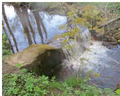
Sohlabsturz aus Beton im Forellenbach vor der baulichen Umsetzung im Jahr 2019 (oben) und Sohlgleite kurz nach der baulichen Umsetzung (rechts)
