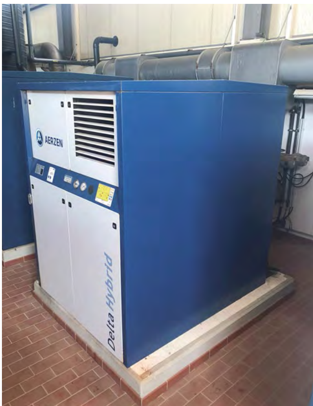
Erweiterte Gebläsestation zur Optimierung der Phosphorelimination (links) und P-Fällmittel-Dosierstation mit Online-P-Messung zur Optimierung der Phosphorelimination auf der Kläranlage Werder (Havel) (rechts)
