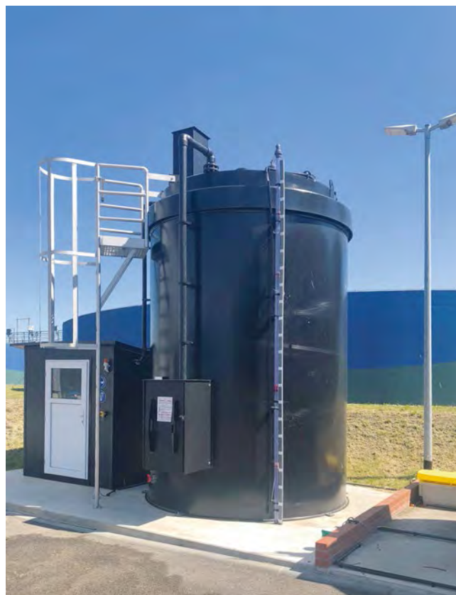
Erweiterte Gebläsestation zur Optimierung der Phosphorelimination (links) und P-Fällmittel-Dosierstation mit Online-P-Messung zur Optimierung der Phosphorelimination auf der Kläranlage Werder (Havel) (rechts)
