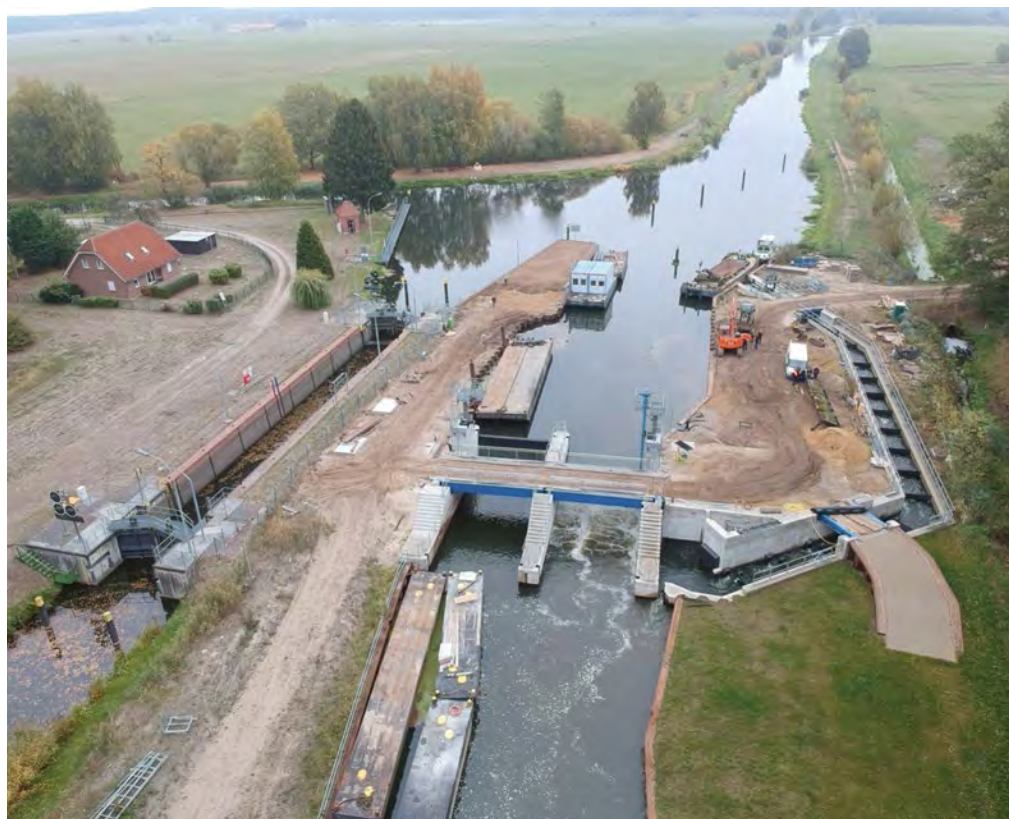
Fischaufstiegsanlage Malliß während der Bauphase
