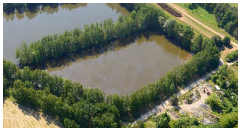
Blick auf das erste Becken der Grubenwasserreinigungsanlage Vetschau mit noch sichtbaren Einschränkungen der Wasserqualität.
