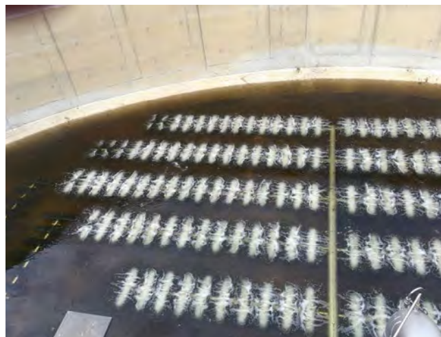
Erneutes Belüftungselement zur Optimierung der Phosphorelimination auf der Kläranlage Werder (Havel) (links) und in Betrieb (rechts)
