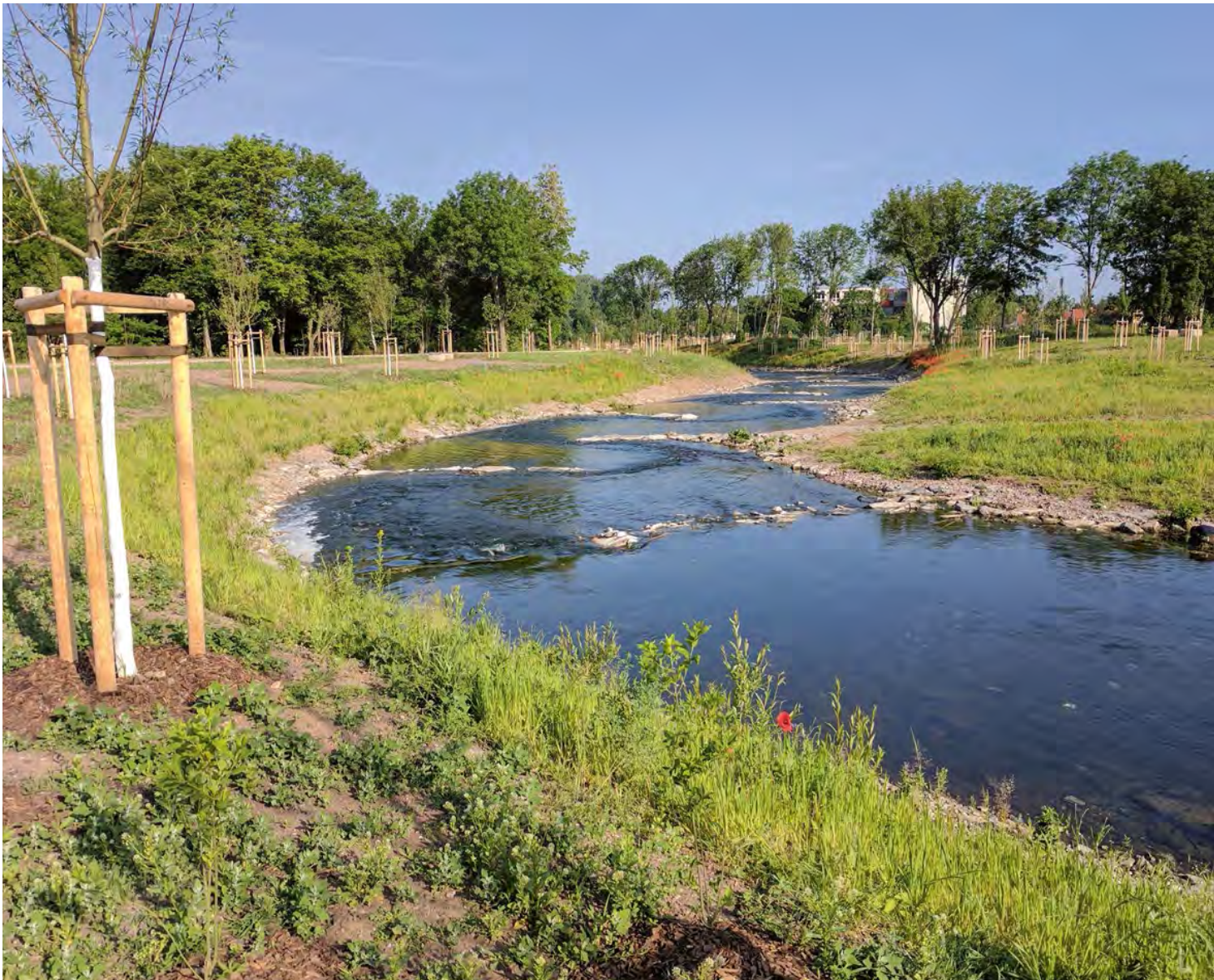
Das Kraftwerksgelände mit Uferpartie im Rückstaubereich der Wehranlage in Erfurt-Gispersleben vor der Umgestaltung (2013, oben). Mit der Beseitigung des Wehrs konnte auch der zuvor gestreckte Lauf der Gera naturnäher gestaltet werden (2017, unten)
