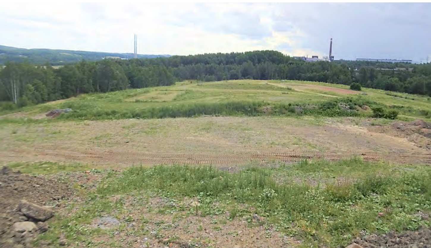
Bilddokumentation der Fertigstellung des Abdeckkörpers in einem Teilbauabschnitt mit Zwischenbegrünung (Stand 2021)
