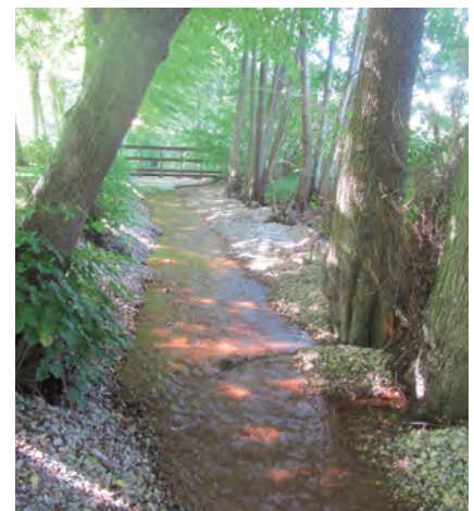
Sohlabsturz aus Beton im Forellenbach vor der baulichen Umsetzung im Jahr 2019 (oben) und Sohlgleite kurz nach der baulichen Umsetzung (rechts)
