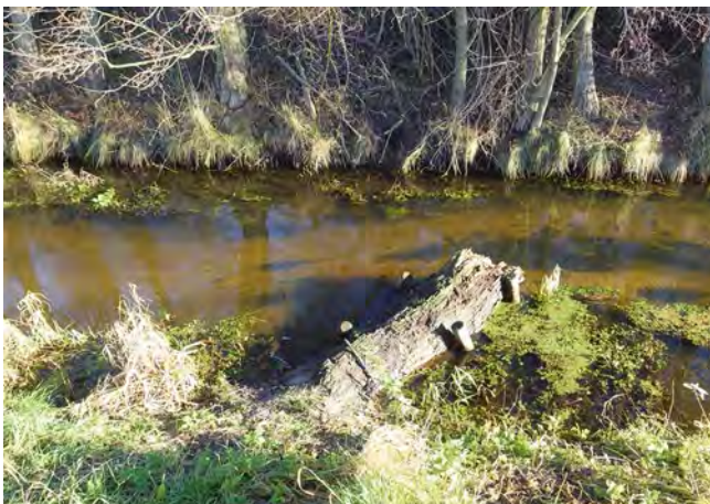
Totholzeinbau am Standort des ehemaligen Wehres Klein Schwarzlosen im Lüderitzer Tanger
