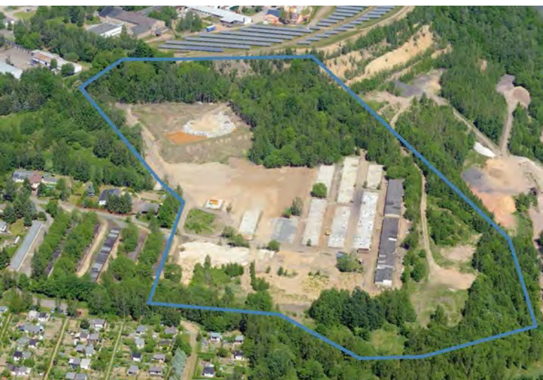
Luftbild Spülhalde Hammerberg (2012) – Vorbereitung der Sanierungsmaßnahmen mit Abriss der zwischenzeitlich dort errichteten Garagen
