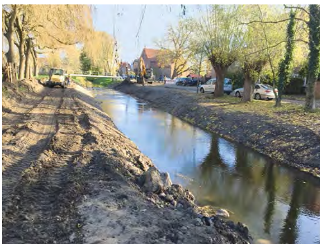
Bauwerk 1 – Beckenpass am Wehr Neue Mühle im Bau
