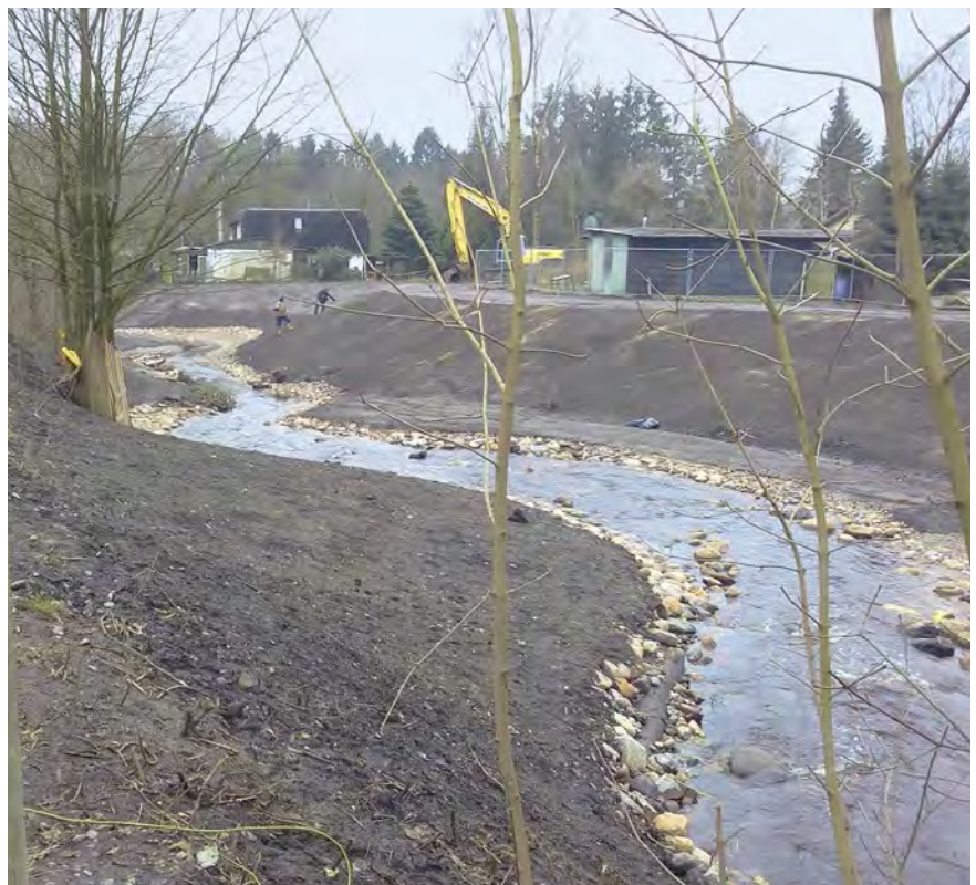
Bauarbeiten am Gewässerbett
