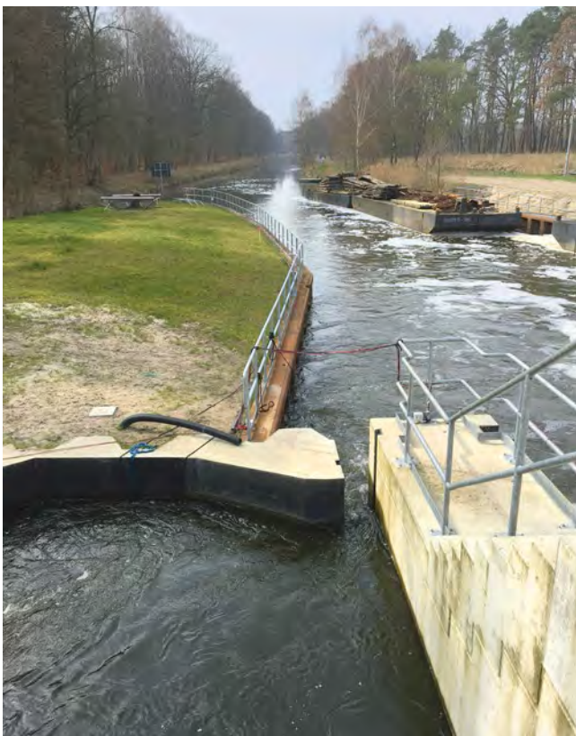
Fischaufstiegsanlage Malliß nach Fertigstellung
