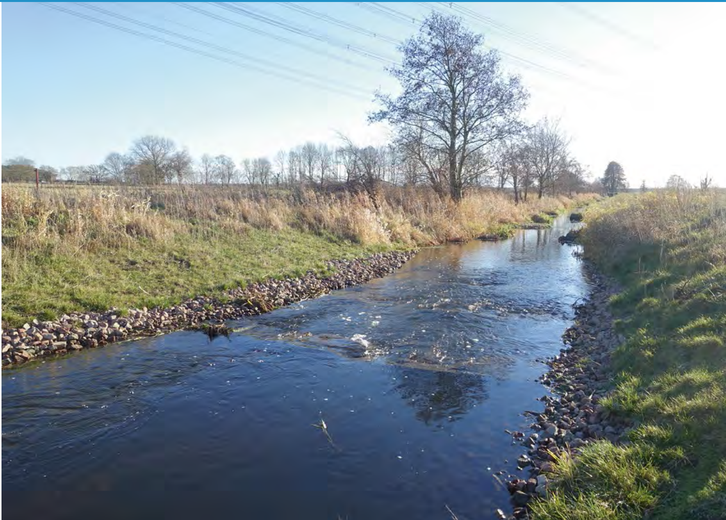
Raugerinne im Lüderitzer Tanger nach dem Rückbau des Wehres Stegelitz
