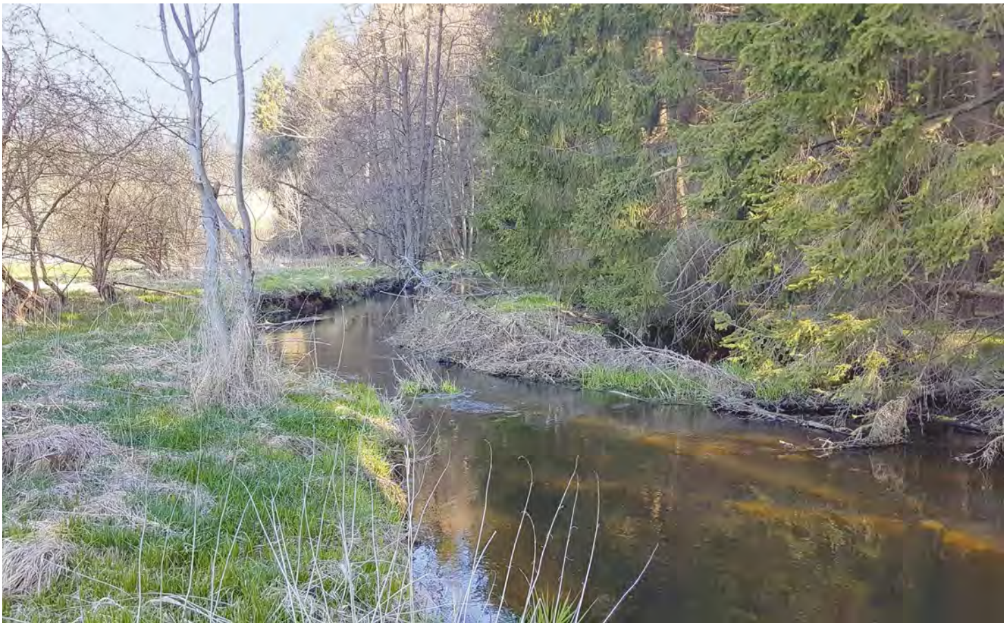
Raubäume als Beitrag zur Gewässerentwicklung und als Unterstand für Fische
