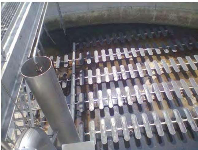
Erneutes Belüftungselement zur Optimierung der Phosphorelimination auf der Kläranlage Werder (Havel) (links) und in Betrieb (rechts)
