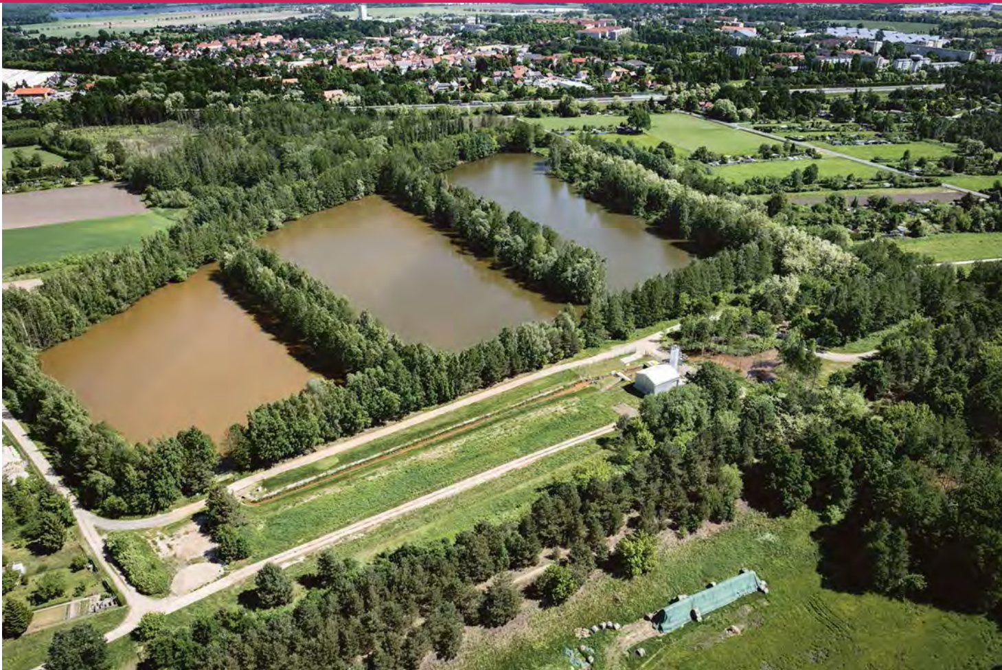
Luftbild der Grubenwasserreinigungsanlage Vetschau mit sichtbarer Abnahme des Eisengehaltes in mäandrierender Fließrichtung vom linken zum rechten Becken
