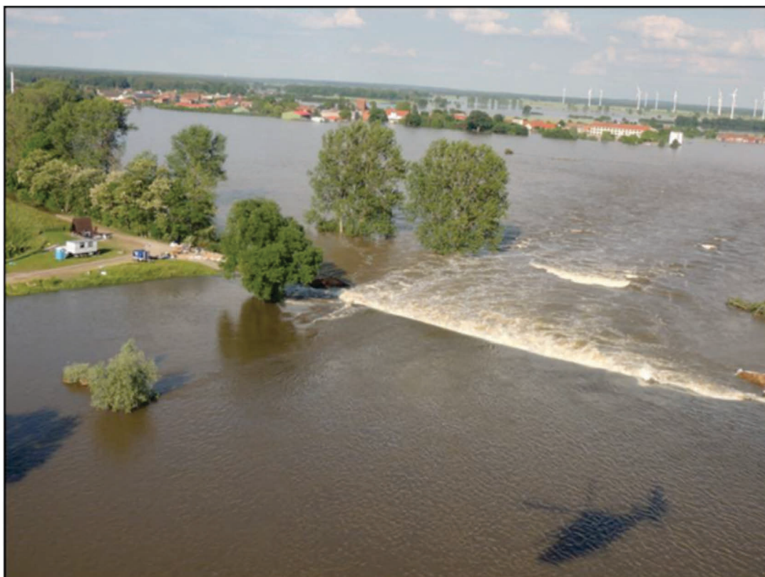
Abbildung 3-4: Deichbruch bei Fischbeck/Elbe (Quelle: LHW)
