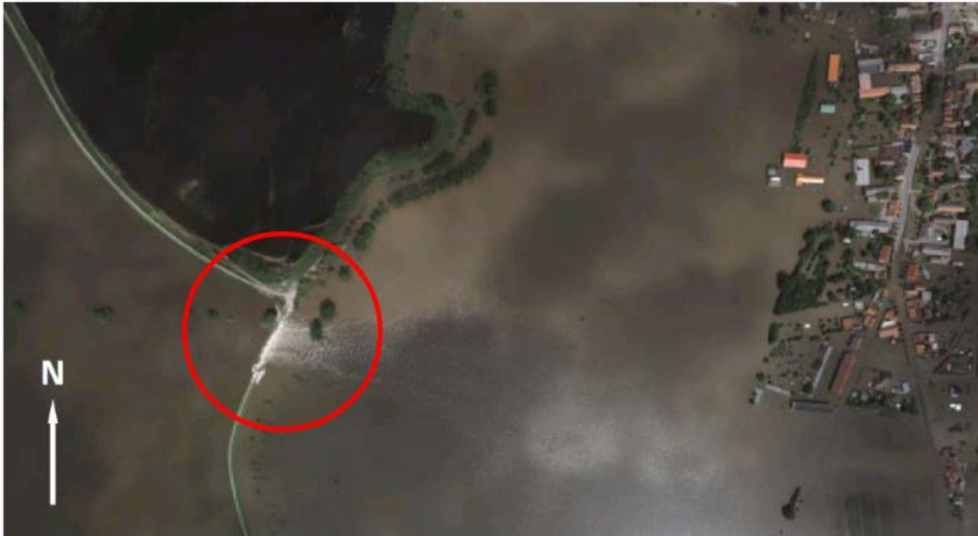
Abb. 3-11: Aufnahme des Deichbruchs bei Fischbeck vom 11.06.2013 [2]
