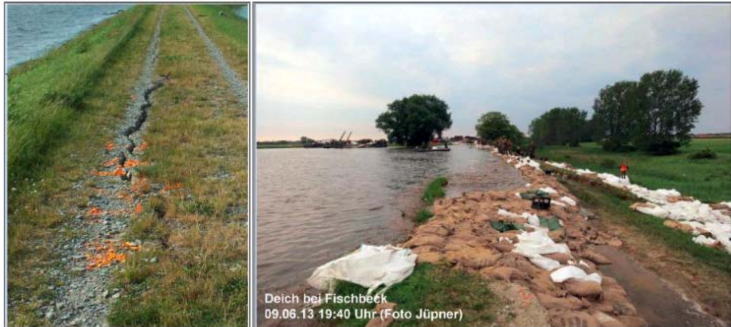
Abb. 3-7: Riss im Deich Fischbeck (links) und Deichverteidigungsmaßnahmen (rechts) [Quelle: LHW]
