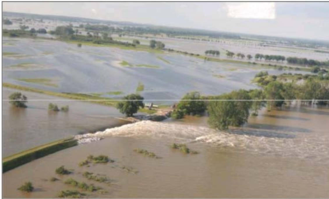
Abb. 3-9: Deichbruch bei Fischbeck vom 10.06.2013 gegen 18.00 Uhr (Blickrichtung gegen Fließrichtung) [20]
