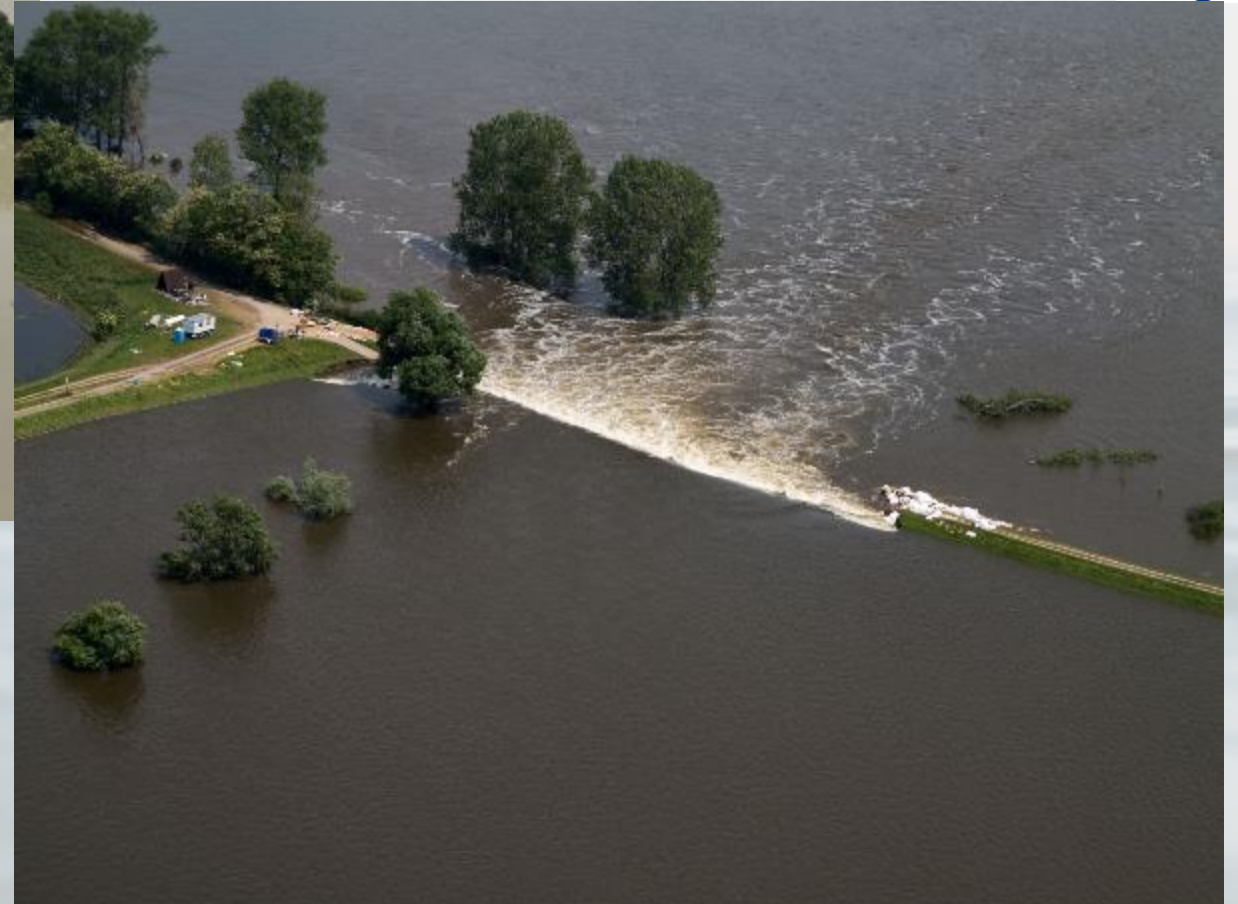
Der Deichbruch bei Fischbeck am 10.06.2013 (Quelle: Sven Schulz, Ministerium für Wissenschaft, Energie, Klimaschutz und Umwelt Sachsen-Anhalt)
