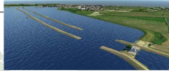
MV: Rückverlegung Hafendeich und Elbedeich Boizenburg, Neubau Sudesperrwerk
