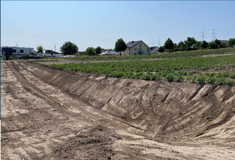
05.06.2023 Rückhalte Damm (Erdbecken)
