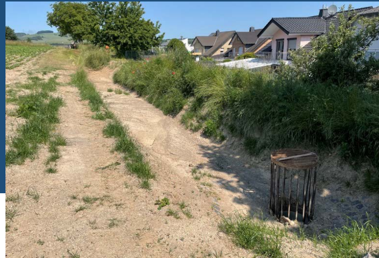
05.06.2023 Wassergraben mit Kanalanschluss
