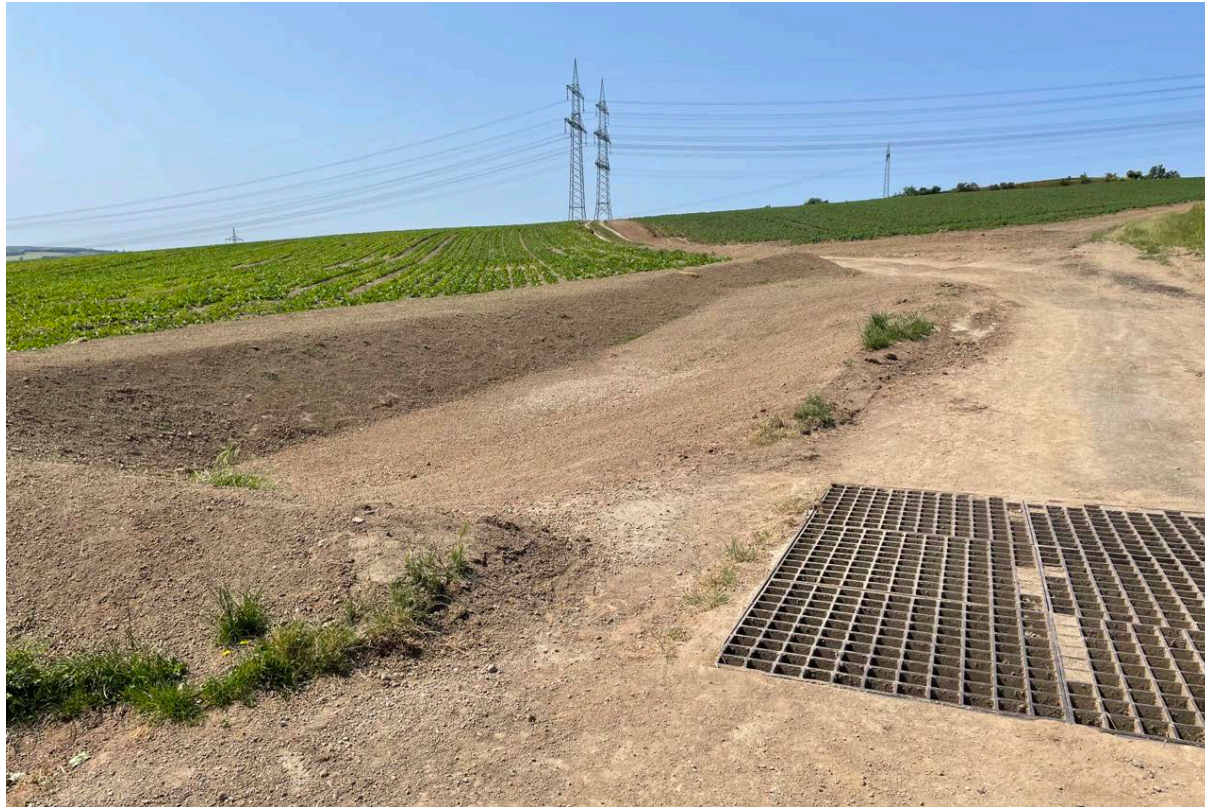
Bestehender Sand- und Geröllfang (Betonbecken)
