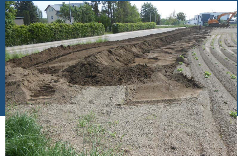
16.05.2023 Rückhalte Damm (Erdbecken)
