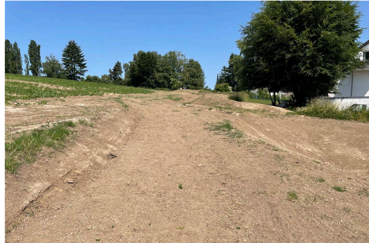
Zusätzlich wurden Erdbecken in Kaskade und Notwasserwege angelegt
