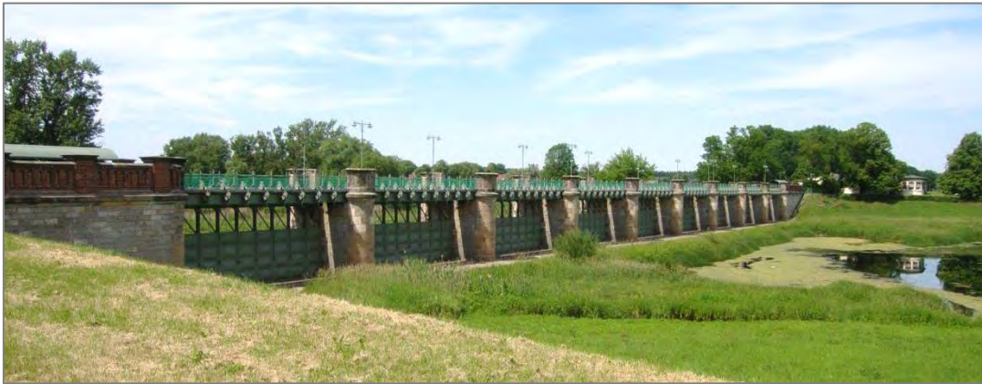
Abbildung 26: Pretziener Wehr von oberstrom am 07.06.2016
