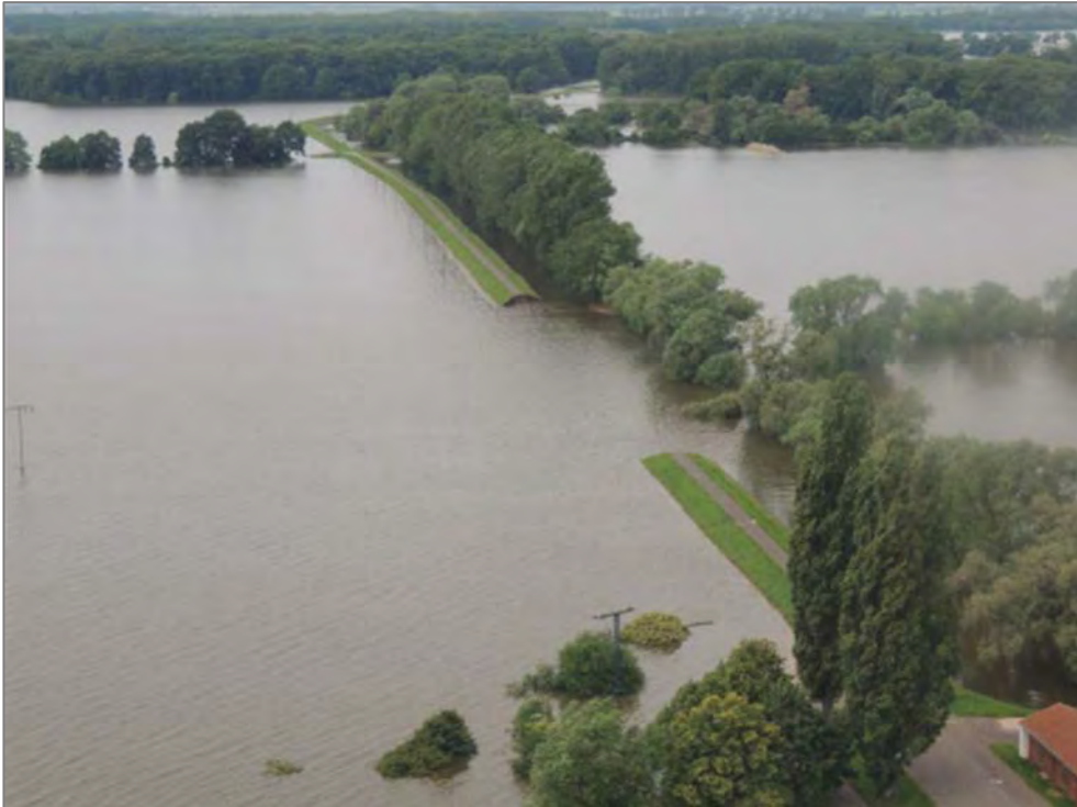
Abbildung 20: Luftaufnahme Deichbruchstelle Saaledeich bei Breitenhagen, 13. Juni 2013 (Quelle: LHW)
