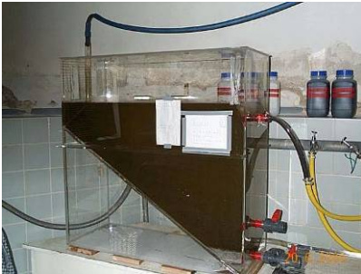
Abb. 4.2: Sedimentationsbecken der ARGE Elbe
