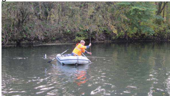
Abbildung 7: Peilstangensondierungen Bode Nienburg
