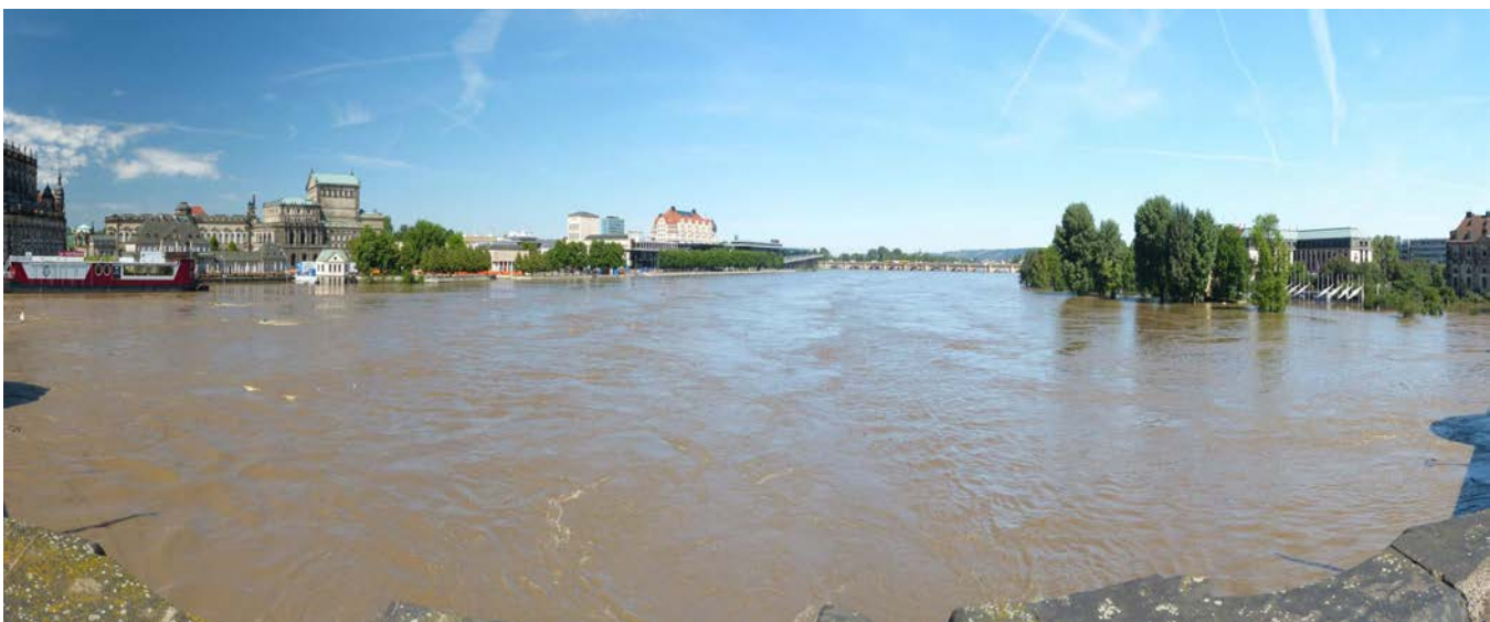
Augustusbrücke in Dresden zum Elbe-Hochwasser 2013
