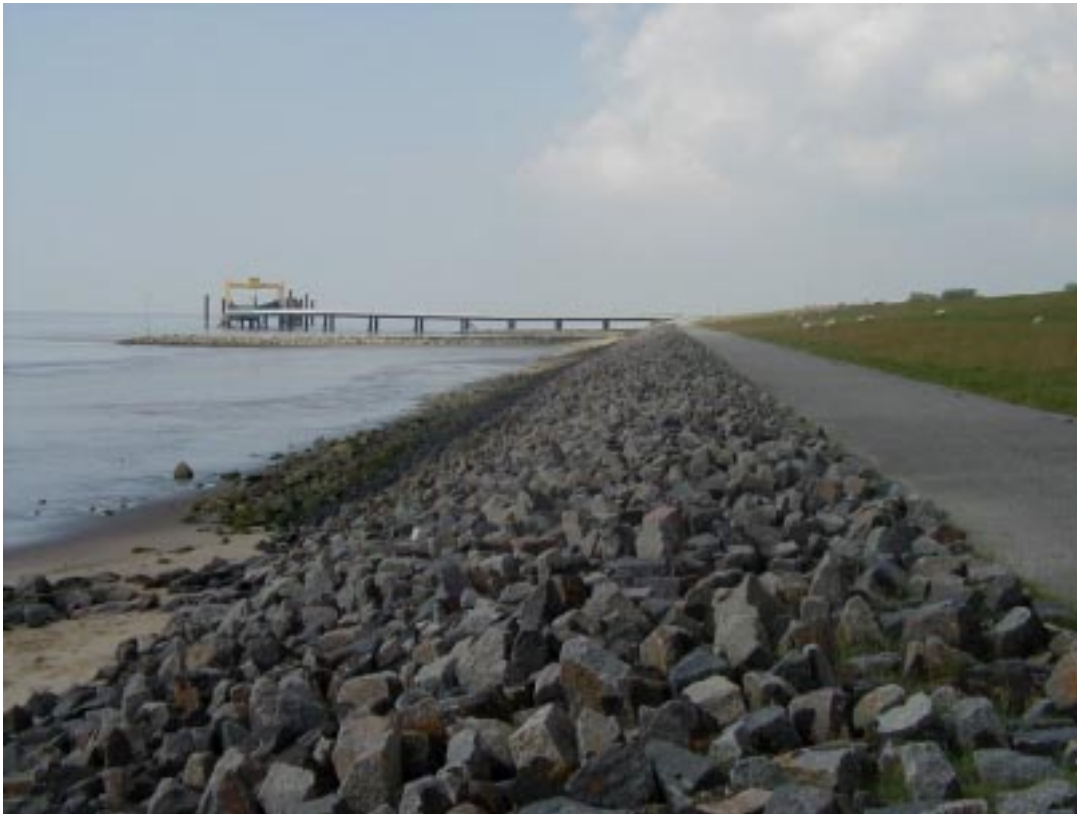
Foto 11: Steinschüttung ohne jeglichen Bewuchs höherer Pflanzen am Fähranleger Brunsbüttel (Kategorie Übergangsgewässer).
