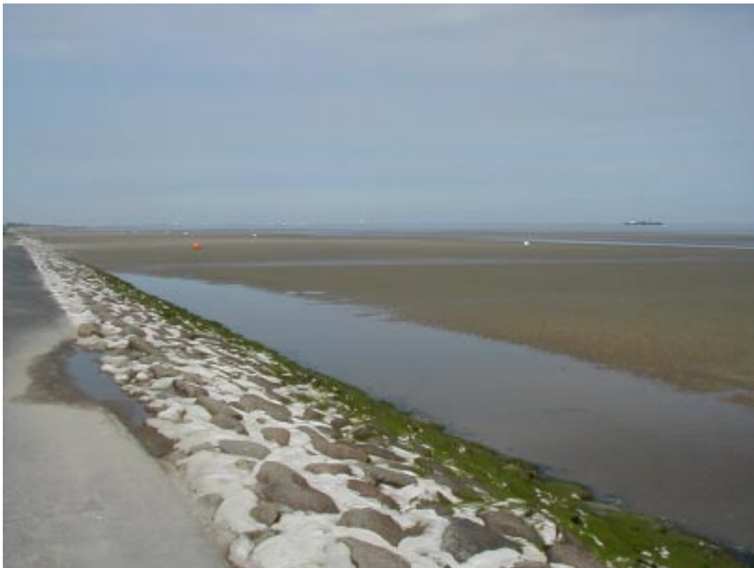
Foto 12: Ufer mit Steinschüttung und Verbund bei Otterndorf, im unteren Bereich mit Algenaufwuchs (Kategorie Übergangsgewässer).
