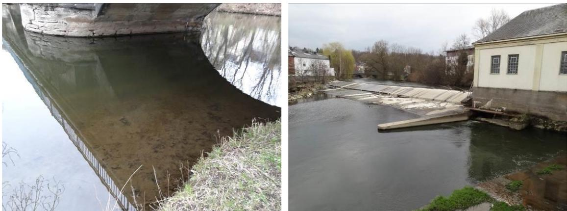
Abb. 21: Fotos Hospitalmühle (10) Schlammbank unter der Brücke im Rückstauraum und Blick auf die Wehranlage (Unterwasser)
