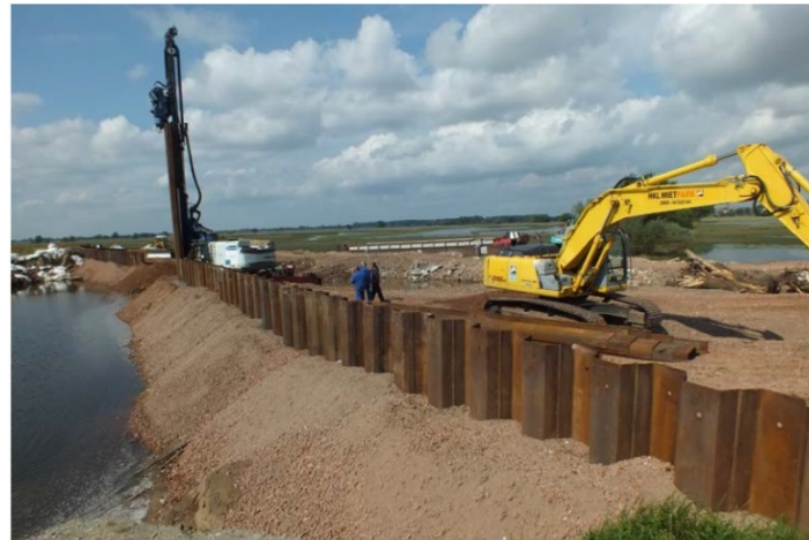
Abbildung 4.5: Wiederherstellung der Deichsicherheit am Deichbruch an der Elbe bei Fischbeck (Quelle: LHW)
