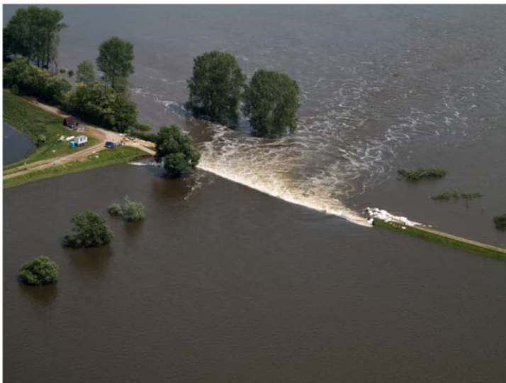
Abbildung 4.4: Deichbruch an der Elbe bei Fischbeck, Sachsen-Anhalt, Juni 2013 (Quelle: LHW)
