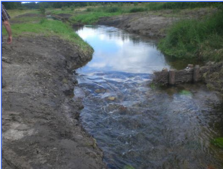
Doppelpfahreihe mit Faschinen als Störelement ca. 2 Wochen nach Einbau
