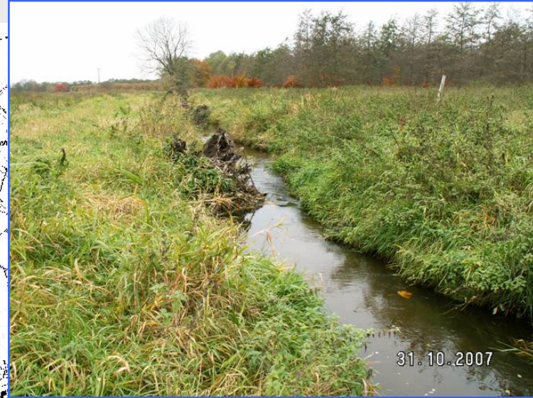
Wurzelballen ca. 3 Monate nach Einbau
