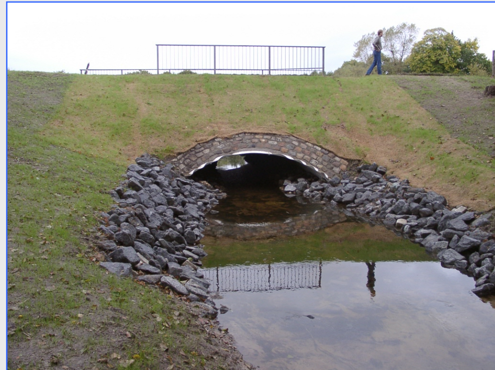
Durchlass im Schlotfelder Graben als Stahlwellprofil
